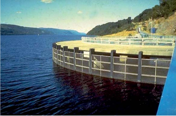
Şekil 5 - İngiltere'de Lock Ness üzerinde hidroelektrik güç istasyonu girişinin ince eleklerle çevrilmesi
