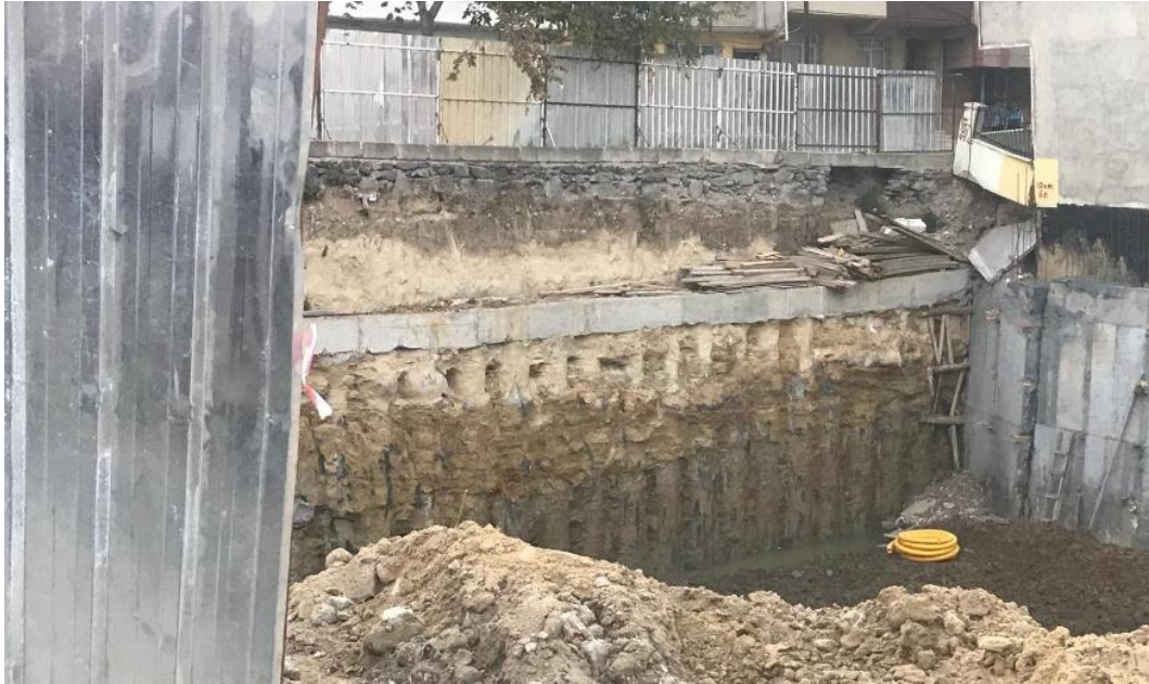
Resim-3 Yol cepheleri mini kazık uygulaması
