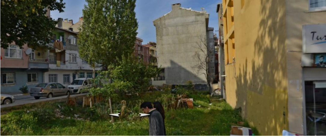
Resim-2 Belediye ekiplerinin yıkmak zorunda kaldığı bina (12 parsel) ve inşaat çalışmasının başladığı 20 Parselin Yandex haritalar uygulamasından alınan fotoğrafı
