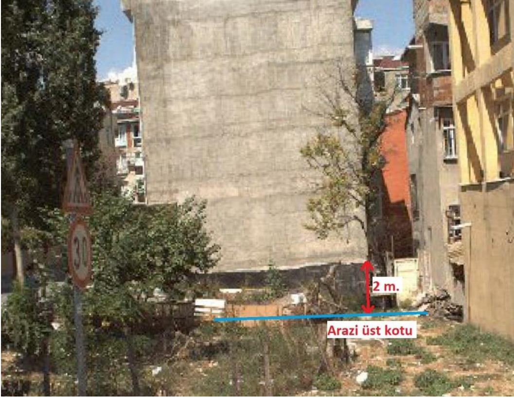
Resim-4 İnşaat Kazısının yapıldığı 20 Parsel doğal arazi kotu ile 12 parsel ilişkisi (Yandex haritalar uygulamasından alınmıştır)
