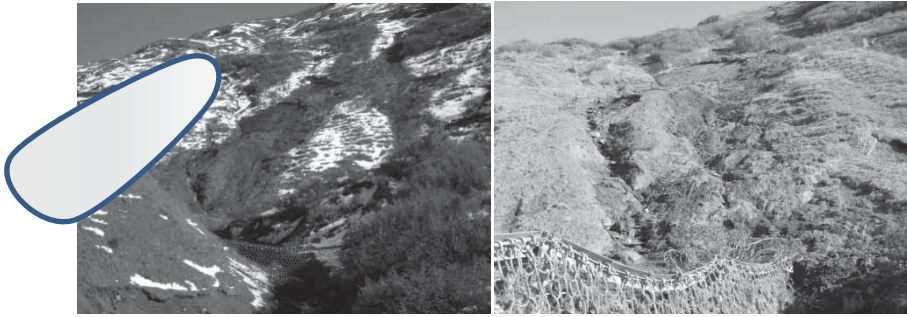
Şekil 6: 2 numaralı bariyere yakın bir heyelan bu bariyerin dolmasına yol açtı
