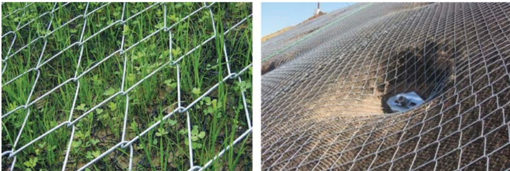
Şekil 1 - Şev stabilizasyonu için yüksek mukavemetli tel ağ (solda) ve yüksek mukavemetli tel ağ şev yüzeyine bastırarak gerilme vermeye yardımcı olan özel tırnaklı plaka (sağda)
