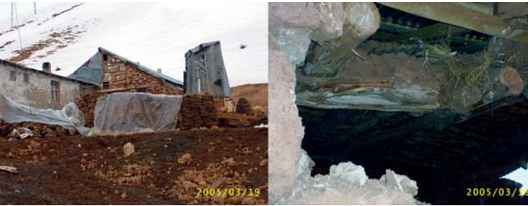
Şekil 4 - Moloz Taş Duvarlı Hafif Çatılı ile Ağır Toprak Damlı Binalar (Çatak)
