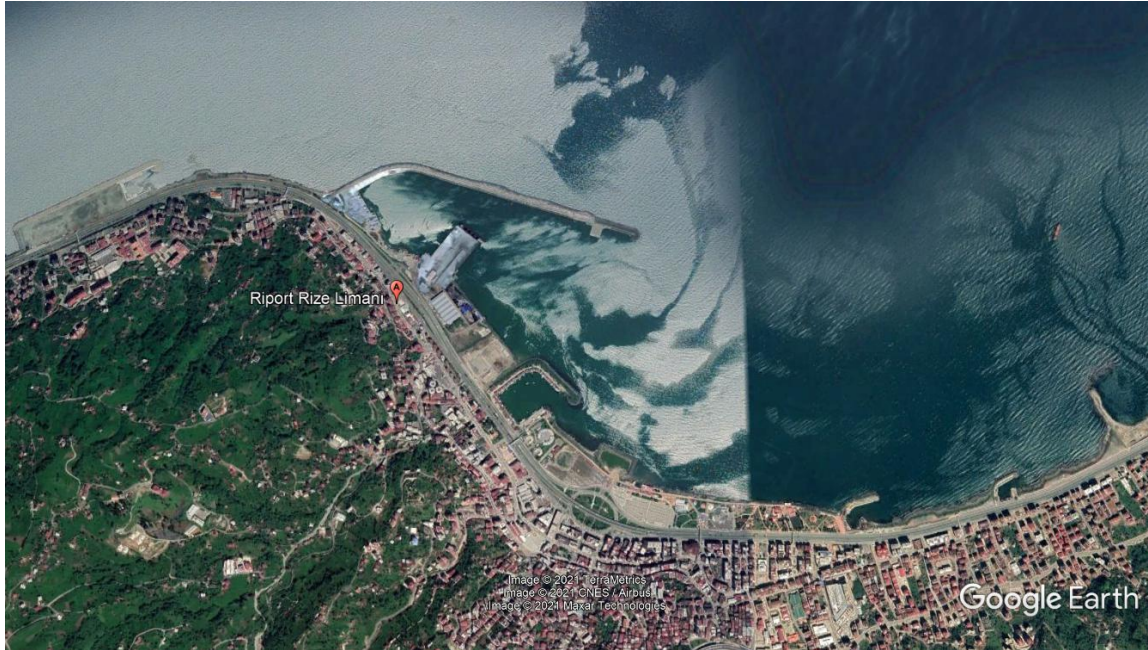
Şekil 3 Riport Rize Limanı görünüşü
