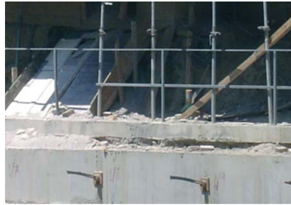
Şekil 6 - B-Blok Cephesi İnklinometre Çukuru
