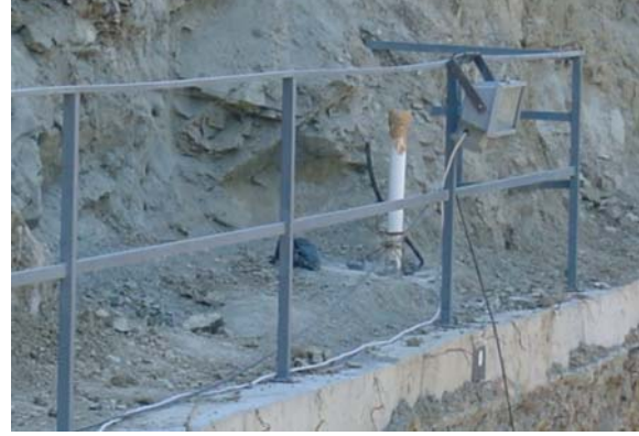
Şekil 5 - Hyatt Reg.Cephesi İnklinometre Çukuru
