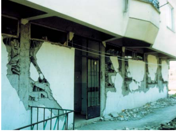
Resim 14 - Kısa Kolon Kırılmasının Olmadığı Düşük Dayanımlı Briket Dolgu Duvarlı Bant Pencere (13 Mart 1992 Erzincan Depremi)
