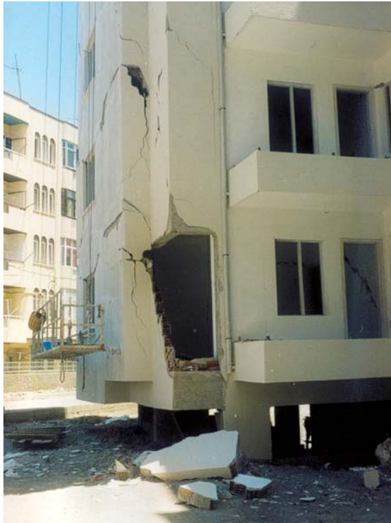
Resim 9 - Betonarme Çerçeve Dışındaki Duvarlar Perde Duvar Gibi Davranır; Duvarda Kesme ve Burulma Kırılması Olur (27 Haziran 1998 Adana-Ceyhan Depremi)
