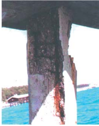
Şekil 1-BOTAŞ-Ceyhan Dört Yol İşletme Tesislerindeki Donatı Korozyonu[4].
