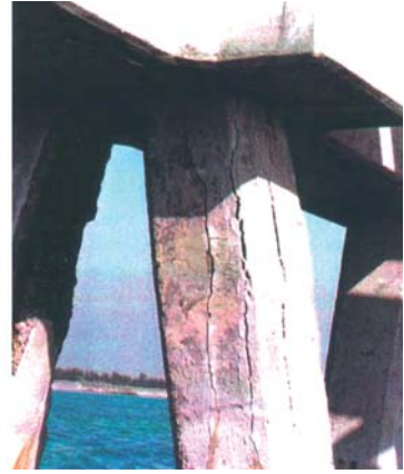
Şekil 1-BOTAŞ-Ceyhan Dört Yol İşletme Tesislerindeki Donatı Korozyonu[4].
