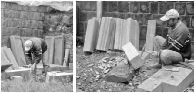
Şekil 15 Taşın şablonlara göre işlenmesi
