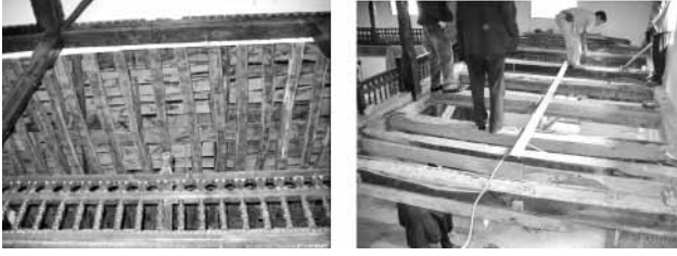
Şekil 14 Mahfil tavan ve döşemesinin onarım-yenilenmesi (Dernekpazarı-Taşçılar Köyü Camii)
