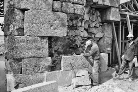
Foto 15 Kemer ayaklarında moloz doku ve yüzey taşı tamamlaması
