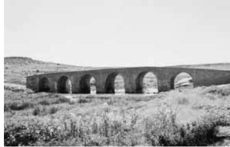
Foto 20 Karaköprü'nün mansap yüzü (restorasyon)
