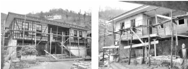
Şekil 13 Medrese binasının duvarlarının onarımı (Dernekpazarı-Taşçılar Köyü Camii)
