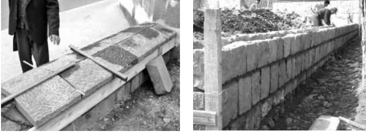
Şekil 25 Avlu etrafına sıralı moloz taş duvar örülmesi ve üzeri doğal taş basık harpuşta yapılması
