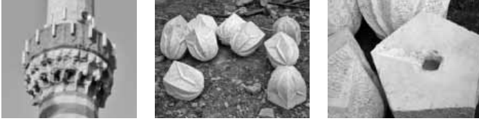
Şekil 13 Şerefe altında bozuk kısımlarında onarılan topuzlar
