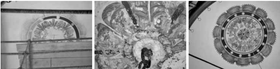
Şekil 23 Kalem işlerinin onarımı.
