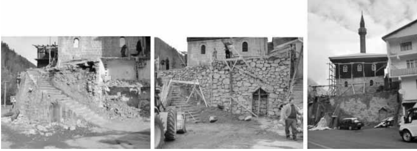
Şekil 24. Onarım sırasında eserin eklerden arındırılması (Çaykara-Taşkiran Camii).
