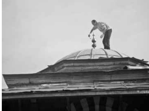
Şekil 3 Alemin temizlenmesi
