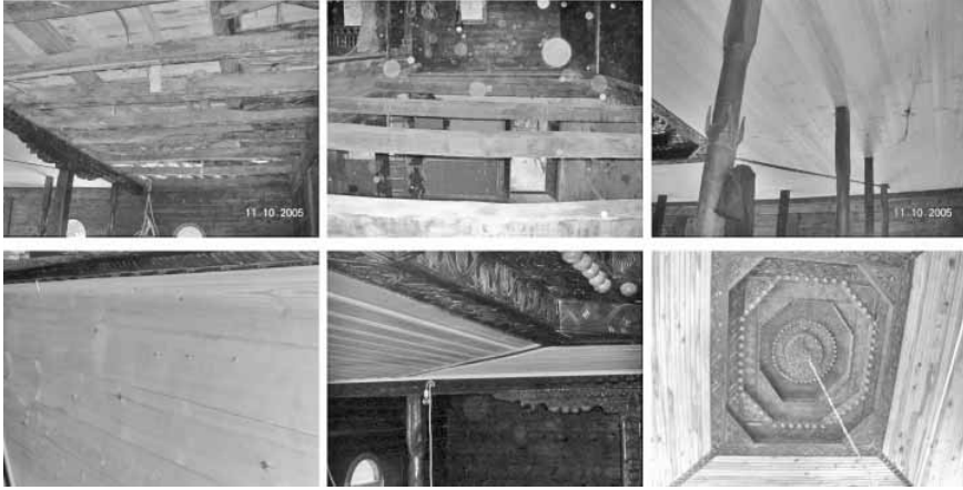
Şekil 25. Onarım öncesi lambri kaplanan tava ve duvarların orijinaline uygun olarak değiştirilmesi (Çaykara-Taşkiran Beldesi Camii).
