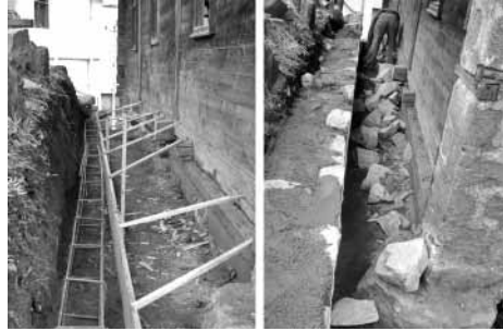
Şekil 28. Drenaj yapımı (Çaykara-Taşkiran Beldesi Camii).
