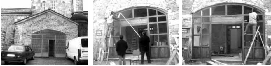
Şekil 15 Mevcut demir kapı doğraması ve yenilenmesi.
