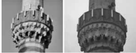
Şekil 14 Şerefe korkuluklarının onarım öncesi ve sonrası durumu
