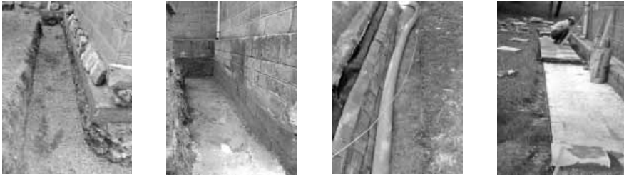
Şekil 23 Cami kuzey ve batı cephesine drenaj yapılması ve doğal taş ile döşenmesi
