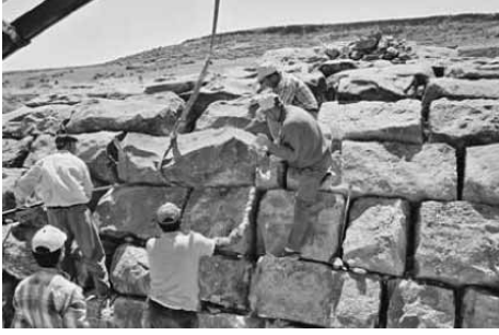
Foto 9 Kemer taşlarında söküm çalışması
