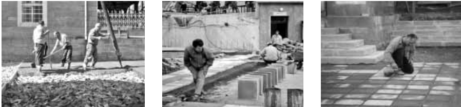
Şekil 24 Cami avlusuna blokaj yapılması, beton dökülmesi, doğal taş örülmesi ve derzlenmesi
