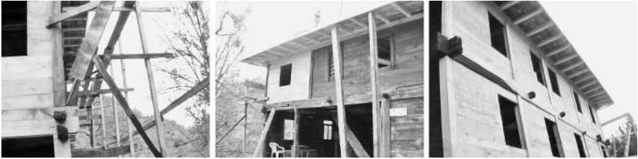
Şekil 11 Dış beden duvarlarının onarımı (Borçka-Düzköy Camii)
