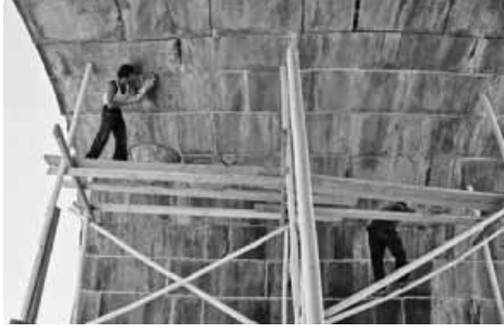
Foto 14 Kemer iç yüzeylerinde derzlerin güçlendirilmesi
