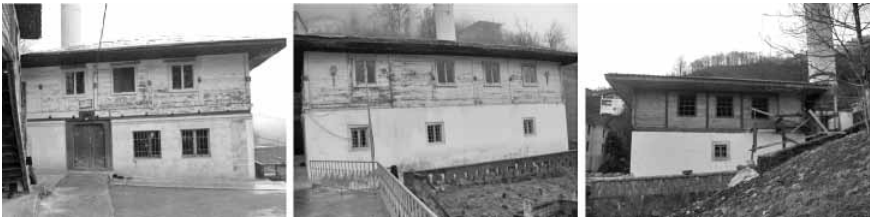
Şekil 12 Onarım öncesi ve sonrası duvarlar (Dernekpazarı-Taşçılar Köyü Camii)
