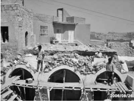
Foto 11 Moloz Taşların Yerleştirilmesi
