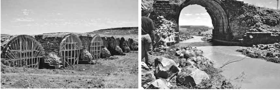
Foto 5 – 6 Köprüde derivasyon çalışması
