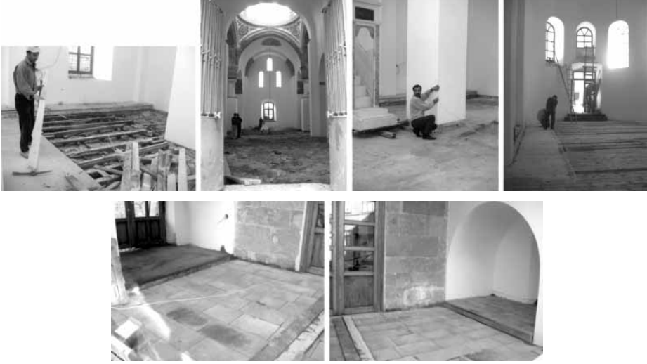
Şekil 24 Ahşap döşemenin yenilenmesi ve son cemaat kısmına taş döşeme yapılması.
