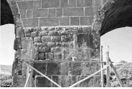
Foto 13 Tempan duvarlarında sağlamlaştırılmış yüzeyler
