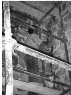
Şekil 20 İç mekânda çatlağa epoksi yapılması.
