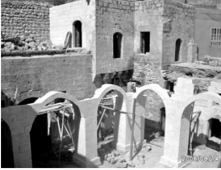
Foto 5-6 Revak Kemerlerinin Yapılması
