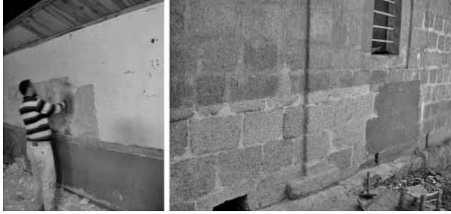
Şekil 22. Lambripler söküldükten sonra itinalı sıva raspası ve dış duvarlarda boya raspası(Çaykara-Taşkiran Camii).
