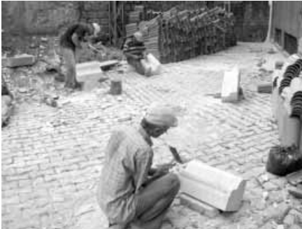
Şekil 5 Söve, silme ve kornişlerdeki taşların hazırlanması
