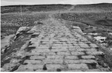
Foto 3 Restorasyon öncesi köprü döşemesi
