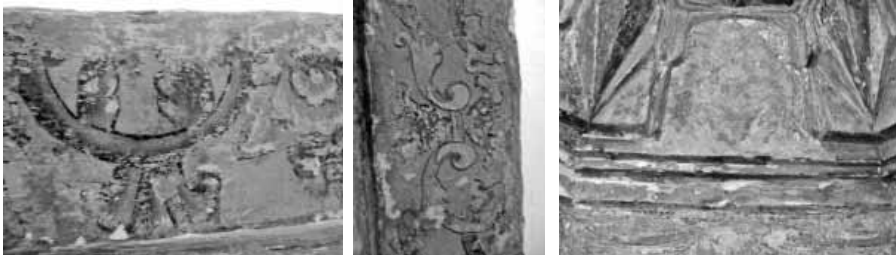
Şekil 8 Onarım sonrası mihrapta ortaya çıkan desenler
