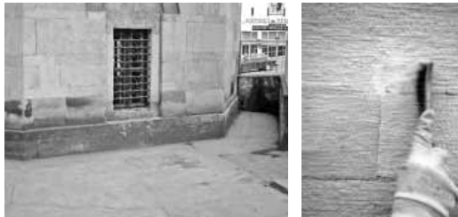
Şekil 11 Hastalıklı taş yüzeyleri ve imitasyon sonrası düzeltilen yüzeyler
