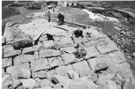
Foto 11–12 Kemer taş aralarında ve yüzeyinde temizleme çalışması.
