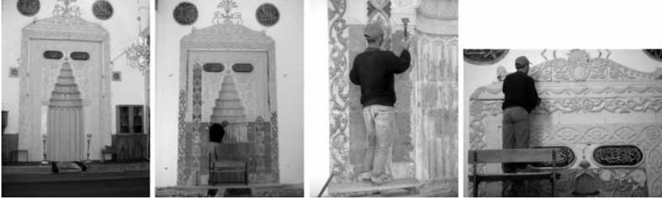
Şekil 26 Mihrabın raspa dilmesi.
