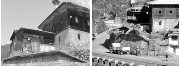
Şekil 23. Onarım öncesinde esere yapılmış olan ekler (Çaykara-Taşkiran Camii).
