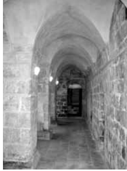
Foto 13,14 Revak Tonozlarının ve Üst Örtüsünün Bitmiş Durumu
