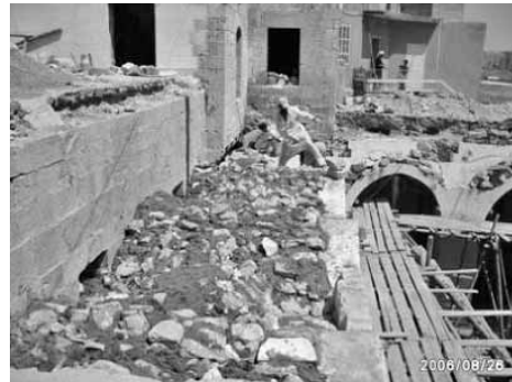
Foto 10 Harcın Üzerine Moloz Taşların Dizilmesi
