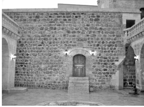
Foto 18 Restorasyon Sonrası Güney Cephesi
