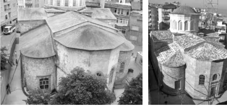
Şekil 12 Çatı onarımı öncesi ve sonrası
