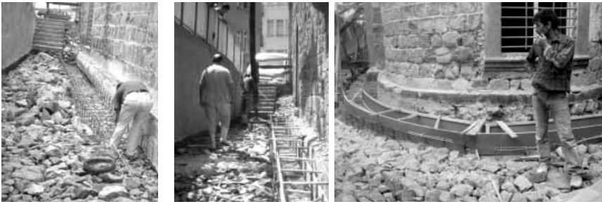
Şekil 16 Güney ve doğu cephesinde yapılan kanal yenilenmesi.
