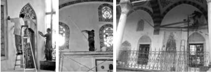
Şekil 10 Yüzeylerde yapılan raspa işlemleri
