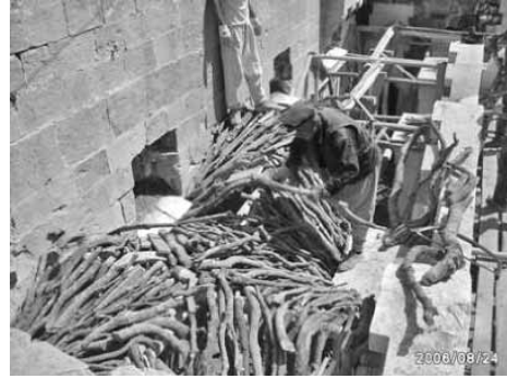
Foto 7-8 Tonz Kalıplarının Kurulması
