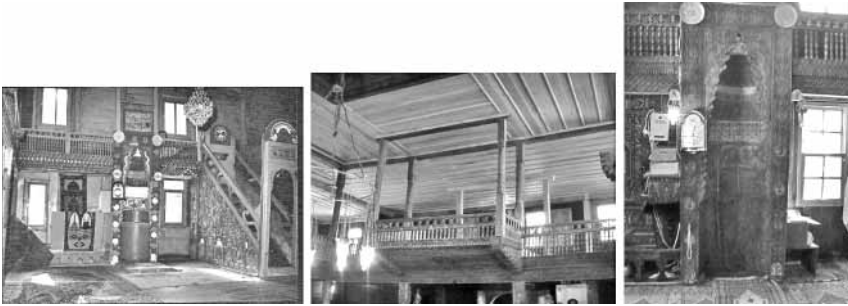
Şekil 20 İç mekanda onarımdan önce boyalı olan ahşap süslemelerin boyadan arındırılması (Borçka-Düzköy Camii).
