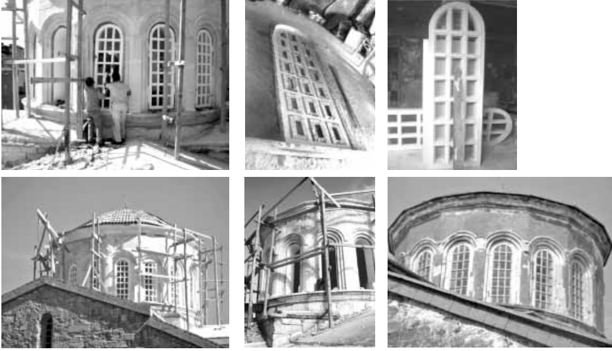
Şekil 9 Kubbe kasmağındaki beton pencerelerin yenilenmesi.
