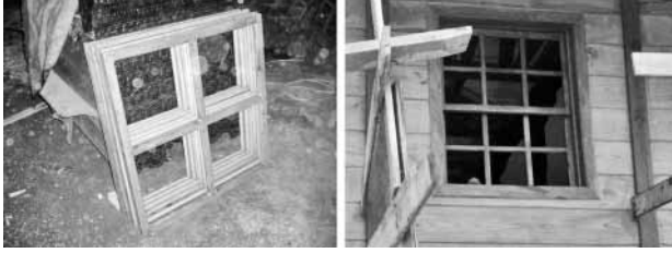
Şekil 17 Pencere doğramalarının yenilenmesi (Dernekpazarı-Taşçılar Köyü Camii).
