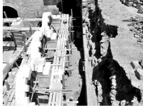
Foto 5-6 Revak Kemerlerinin Yapılması
