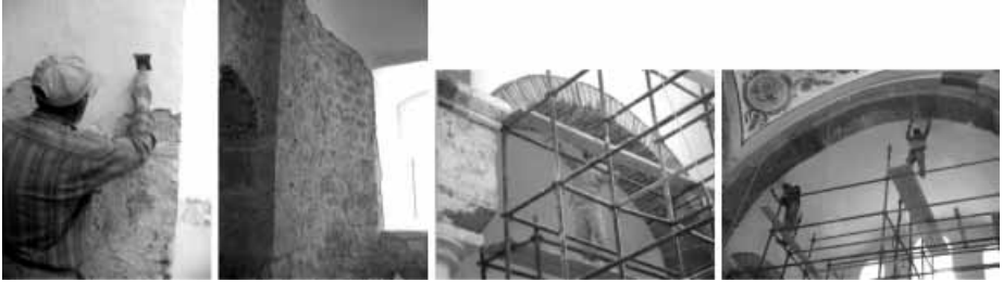
Şekil 19 İç mekânlarda sıvalı yüzeylerde raspa yapılması.
