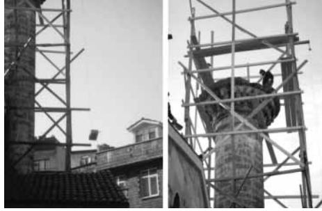
Şekil 27 Minarenin kaideye kadar sökümü.
