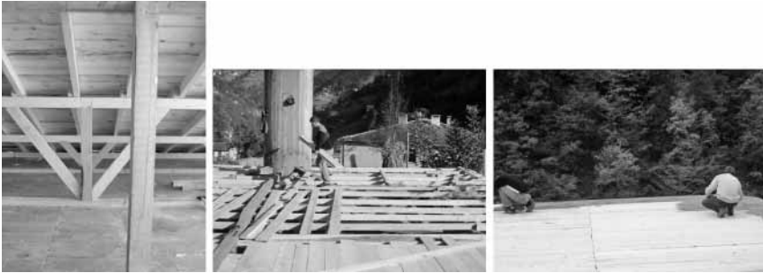
Şekil 9 Çatının bozulan bölümlerinin yenilenmesi (Çaykara-Taşkiran Beldesi Camii)
