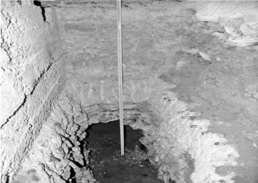
Şekil 7. Açılan araştırma çukuru ve tespit edilen drenaj galerisi.
