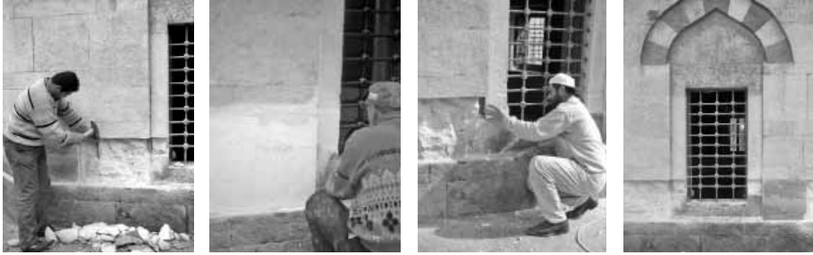
Şekil 12 Türbe beden duvarında yapılan çürütme işlemi
