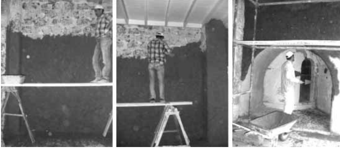
Şekil 21 İç mekânda sıva altı dolgusu yapılması.
