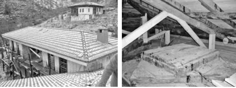
Şekil 10 Çatı örtülerinin değiştirilmesi Çatı konstrüksiyonunun onarımı (Dernekpazarı-Taşçılar Köyü Camii)
