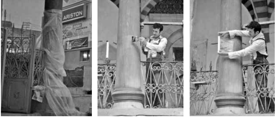
Şekil 1 Sütun temizliğinde AB 57 uygulama detayları
