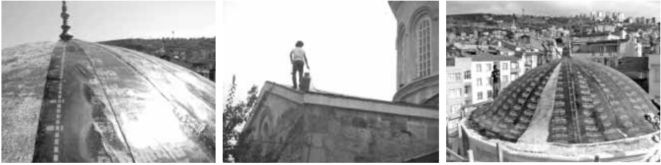
Şekil 10 Çatıda su yalıtımı yapılması.
