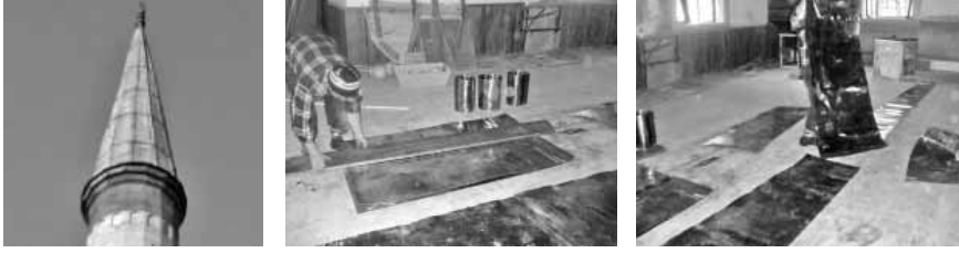
Şekil 21 Mevcut külahın durumu ve yenilenen kurşun malzemenin hazırlanması
