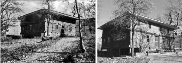
Şekil 29 Artvin-Borçka Düzköy camii onarım öncesi ve sonrası genel görünüm.
