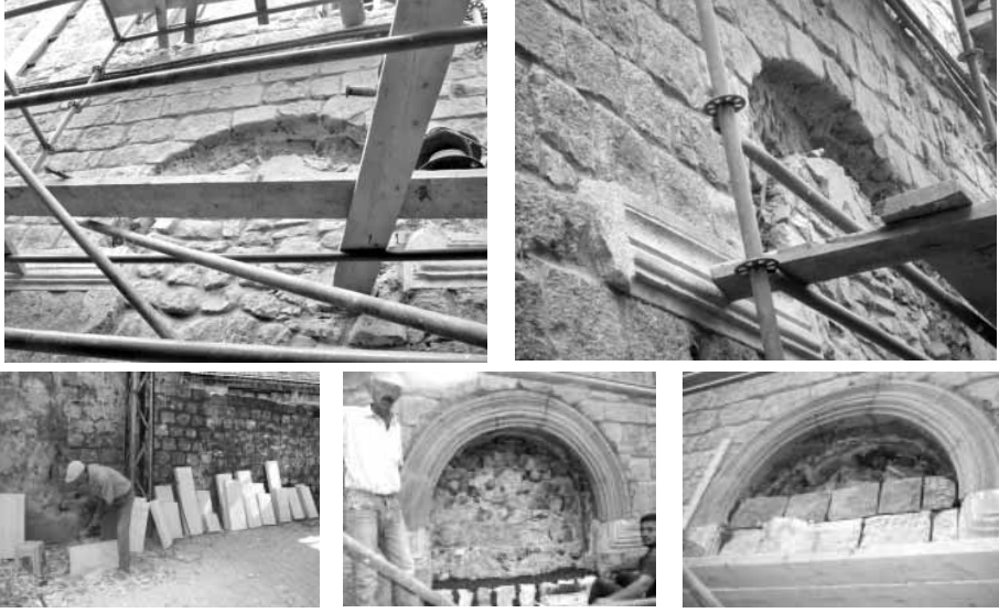
Şekil 6 Dış cephedeki kemerlerin onarımı
