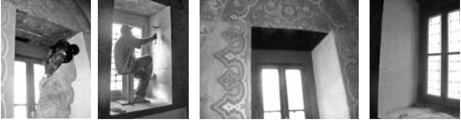
Şekil 9 Türbe pencere iç mekânlarının yan ve üst yüzeylerinin temizlenmesi
