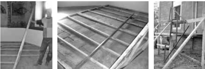
Şekil 22 Türbe içi seyyar döşeme yapılması
