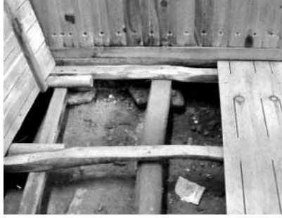
Şekil 15. Harim kısmında onarım öncesi mevcut döşeme (Çaykara-Taşkiran Camii)
