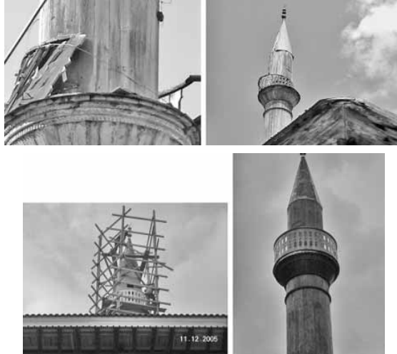
Şekil 19 Ahşap minarenin bozuk bölümlerinin onarımı ve yenilenmesi (Çaykara-Taşkıran Camii).
