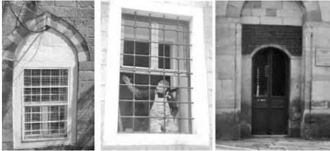
Şekil 17 Pencere ve kapıların orijinaline göre yenilenmesi
