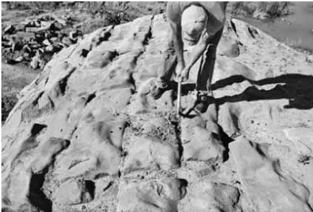
Foto 11–12 Kemer taş aralarında ve yüzeyinde temizleme çalışması.
