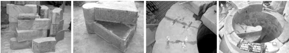
Şekil 28 Minare merdiven basamaklarının yapımı.
