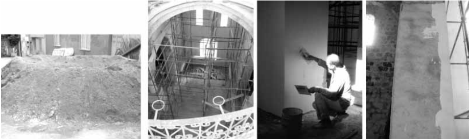
Şekil 22 Kireç harçlı sıva yapımı.
