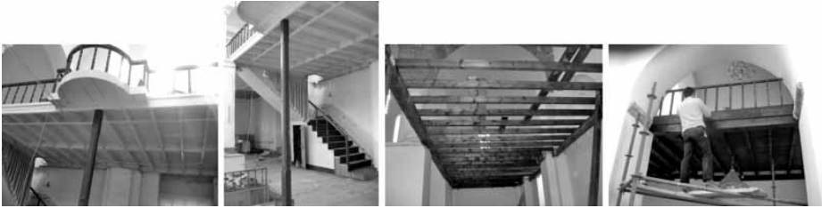
Şekil 25 Ahşap mahfilin yenilenmesi.
