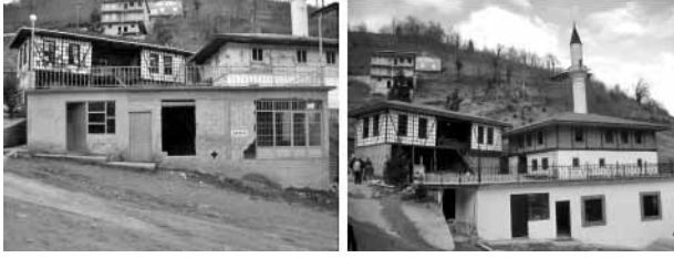
Şekil 30 Trabzon-Dernekpazarı Taşçılar köyü camii onarım öncesi ve sonrası
