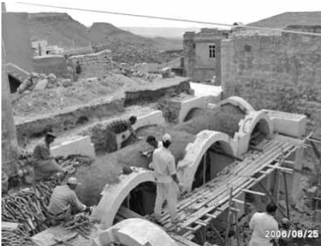
Foto 9 Çamur Harcın Tonz Kalıpların Üstüne Dökülmesi
