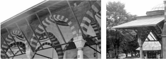
Şekil 20 Sundurma ve üzerinde yer alan kurşun örtünün onarım sonrası durumu
