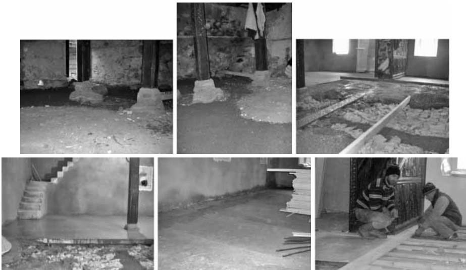
Şekil 16 Caminin taban döşemesinin yapımı (beton üzerine kadronlu ahşap döşeme). (Çaykara-Taşkiran Camii)
