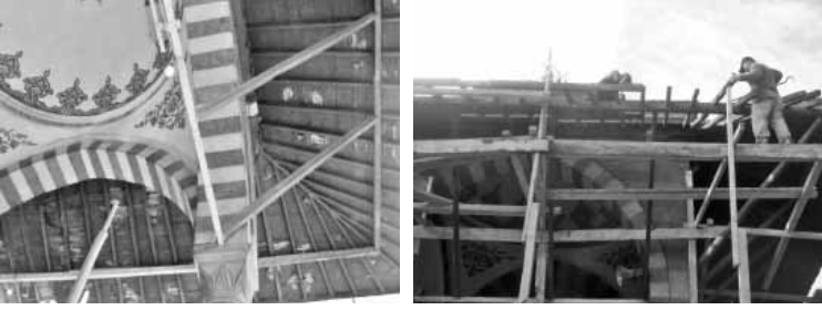
Şekil 18- Çürüyen ahşap sundurma ve sökümü
