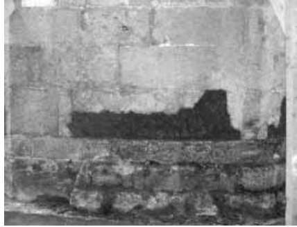
Şekil 4 Taş yüzeylerde yapılan imitasyon işlemleri.
