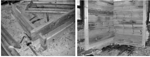
Şekil 18 Boğaz geçme duvarların bozuk olan bölümlerinin onarım ve yenilenmesi (Çaykara-Taşkıran Camii).
