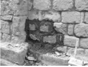
Şekil 3 Taş yüzeylerde yapılan çürütme işlemleri.
