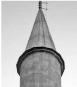
Şekil 33 Minare külâhının yapımı.
