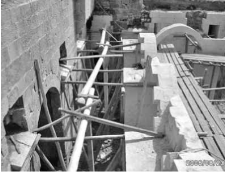
Foto 7-8 Tonz Kalıplarının Kurulması
