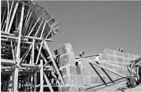
Foto 16 Kemer ve tempan duvarında tamamlama
