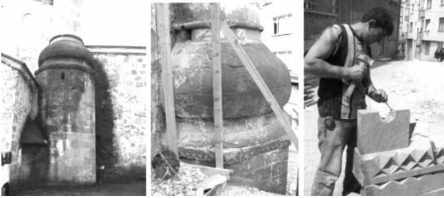
Şekil 32 Minare kaidesinin onarımı.
