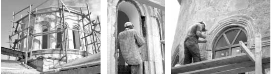
Şekil 7 Dış cephedeki pencere sövelerinin onarımı
