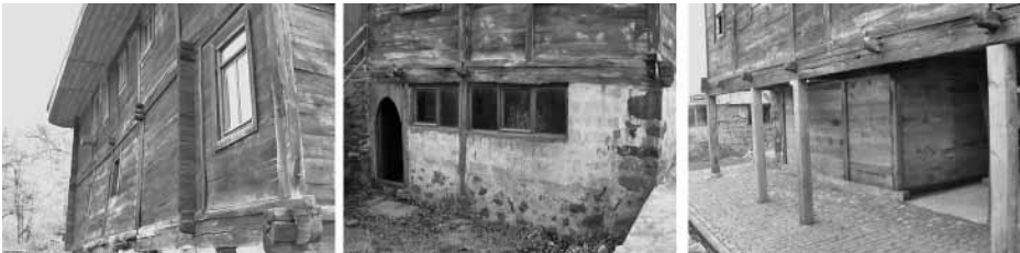
Şekil 7 Borçka Düzköy Camiinde sağlamlaştırılan duvarlar.
