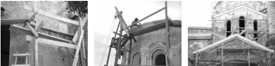
Şekil 8 Dış cephedeki silme ve kornişlerin onarımı
