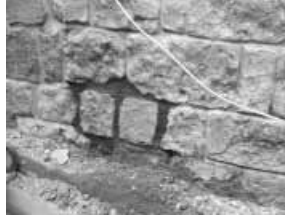
Şekil 3 Taş yüzeylerde yapılan çürütme işlemleri.
