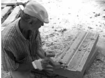
Şekil 5 Söve, silme ve kornişlerdeki taşların hazırlanması
