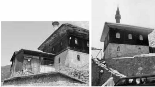
Şekil 31 Trabzon-Çaykara Taşkiran beldesi camii onarım öncesi ve sonrası
