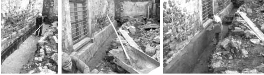
Şekil 18 Batı cephesi drenajı.
