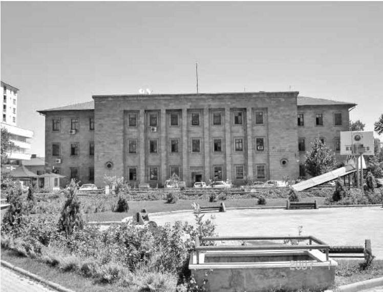
Resim-4:Yapının Güneybatı Cephesi
