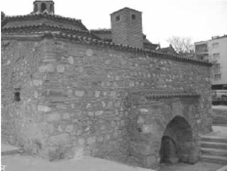
Foto: 3. Manisa - Hüseyin Ağa Hamamı. Doğu cephesinde yapılmı unutulan külhan bacası ve odunluk kesimi
