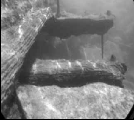
Şekil 14: Konjic Köprüsü, Osmanlılar Dönemi (17. yy), Bosna-Hersek (Ampatman altında bulunan 2 ve 3 sıradan oluşan ahşap ızgaralar)
