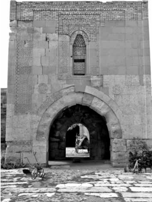
Fotoğraf 3: Aksaray Sultan Han (13. yüzyıl). Onarımda kullanılan farklı malzeme ve yöntemler üslub birliğinden yoksundur.
