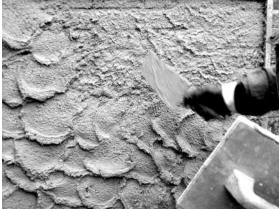
Resim 3. Albaria™ Intonaco ile sıva yapımı
