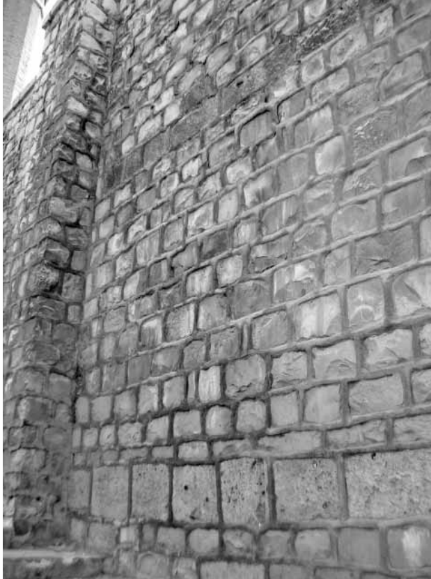
Fotoğraf 5: Konya Alaaddin Camisi (13. yüzyıl). Çimento içerikli kabarık derz uygulamasının özgün biçimiyle bir ilgisi yoktur.
