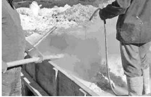
Resim 2. Şantiyede kireç söndürme işlemi
