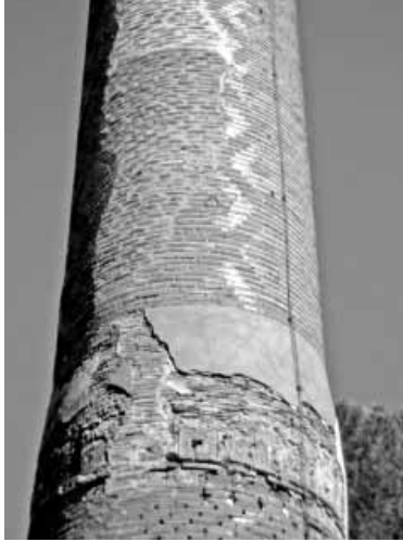
Fotoğraf 14: Birgi Ulu Camii Minaresi (14. yüzyıl). Tuğla gövdedeki çimento içerikli sıva ve derzler çirkin ve uyumsuz.
