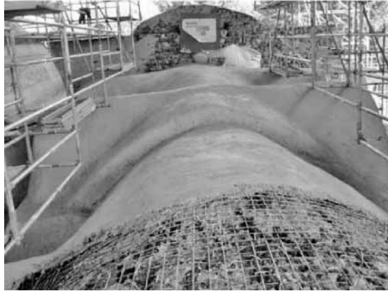
Resim 5. Albaria™ Struttura ile eski bir kilise tonozunun mantolama ile güçlendirilmesi
