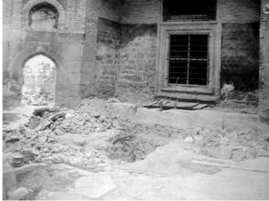
Fotoğraf 1: Konya Sahip Ata Hanikahı (13. yüzyıl). Özgün çini kaplamalar yenileme niyetiyle yerlerinden sökülüp ıskartaya çıkartılmışlardır.
