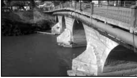
Şekil 19: İstasyon Köprüsü, Amasya
