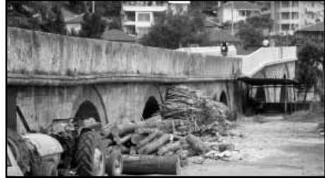
Şekil 23: Ali Fuat Paşa Köprüsü, Sakarya
