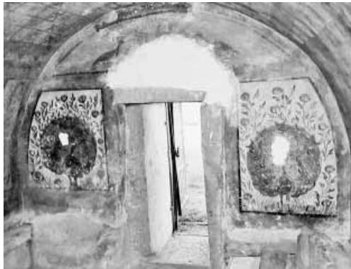
Fotoğraf 15: İznik, Elbeyli Köyü Bizans Hipojesi (4. yüzyıl): Önceki onarımlarda uygulanan alçı sıva özensiz ve uyumsuz.
