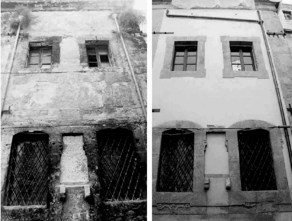
Resim 6. Albaria™ serisi harçlar ile yapı cephesinin yenilenmesi
