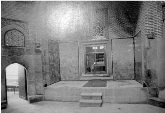
Fotoğraf 2: Konya Sahip Ata Hanikahı (13. yüzyıl). Sökülen özgün çini kaplamalar ikinci bir ihale ile yerlerine yerleştirilerek restore edilmişlerdir.
