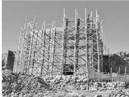
Resim 1. Diyarbakır surlarının Albaria™ harçları ile onarımı
