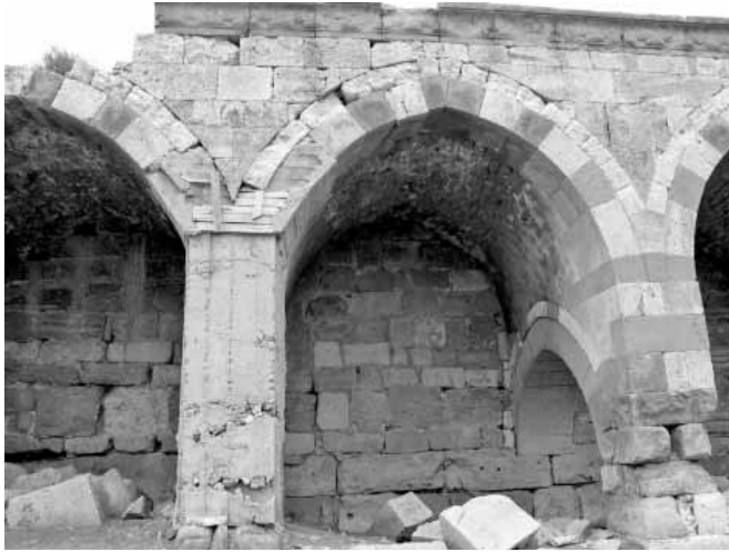
Fotoğraf 12: Zazadin Han (Konya-Aksaray Arasında, 13. yüzyıl). Destek amacıyla yapılan çimento kaplamalı ayağın kalıp izleri ve tattaları halen durmaktadır.
