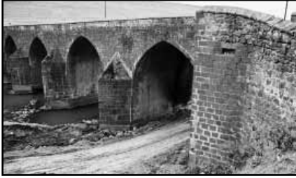
Şekil 22: Dicle Köprüsü, Diyarbakır
