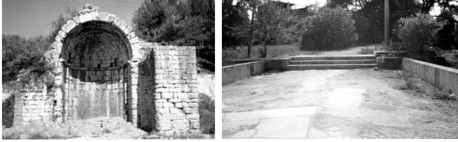
Şekil.6 Köprü'nün doğu ucundaki apsisli yapı ve batı ucundaki zafer takı temelleri.
