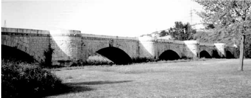
Şekil.3 Köprü gövdesi, ayakları ve kuru nehir yatağı (Güney cephe).
