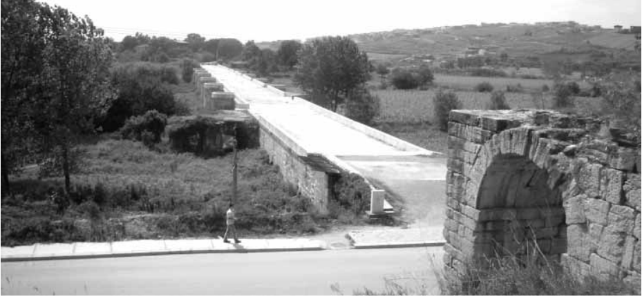
Şekil.5 Köprü gövdesinin genel görünüşü (güneydoğu-kuzeybatı doğrultusu).
