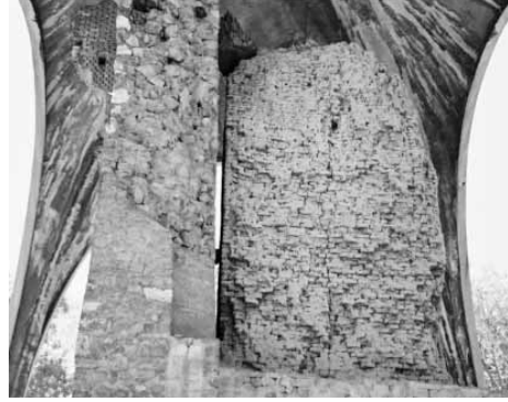
Şekil 16. Kerpiç duvarda düşey yarılmalar başlamıştır
