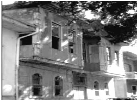
Şekil 3. Turizm Müdürlüğü Binası'nın yenilemeden önceki durumu (Kayalı, 2005)
