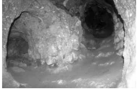
Resim 10: Temizlenmeyen bölümlerden görünüm
