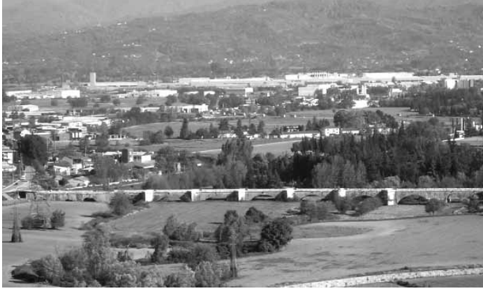
Şekil.1 Köprü'nün kuzeyden görünüşü ve eski nehri yatağı.
