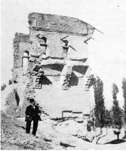
Şekil 3. Yıkılmak üzere olan yapının görünüşü (Sarre, 1967).
