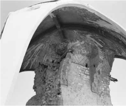
Şekil 13. Konsollarda yapı malzemesi olarak tuğla kullanılmıştır
