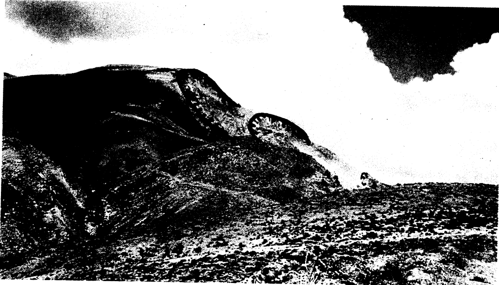
Hindibaba Köyü civarındaki heyelanın genel görünüşü
