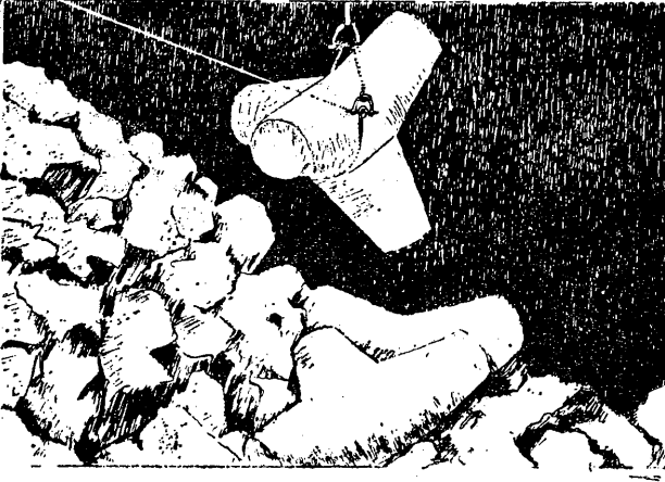
1. TABAKA TETRAPOD YERLEŞTİRİLİŞİ
