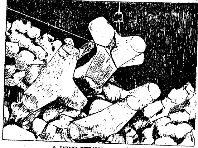
2. TABAKA TETRAPOD YERLEŞTİRİLİŞİ
