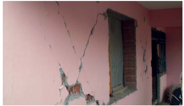
Şekil 4 - Tabanözü köyündeki tipik bir köy konutunda meydana gelen hasar örnekleri
