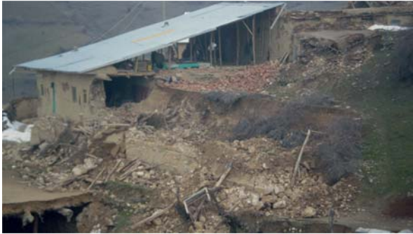
Şekil 7 - Okçular köyündeki yapı enkazları
