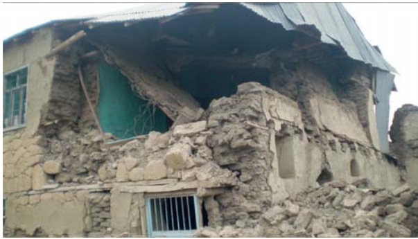
Şekil 4 - Tabanözü köyündeki tipik bir köy konutunda meydana gelen hasar örnekleri
