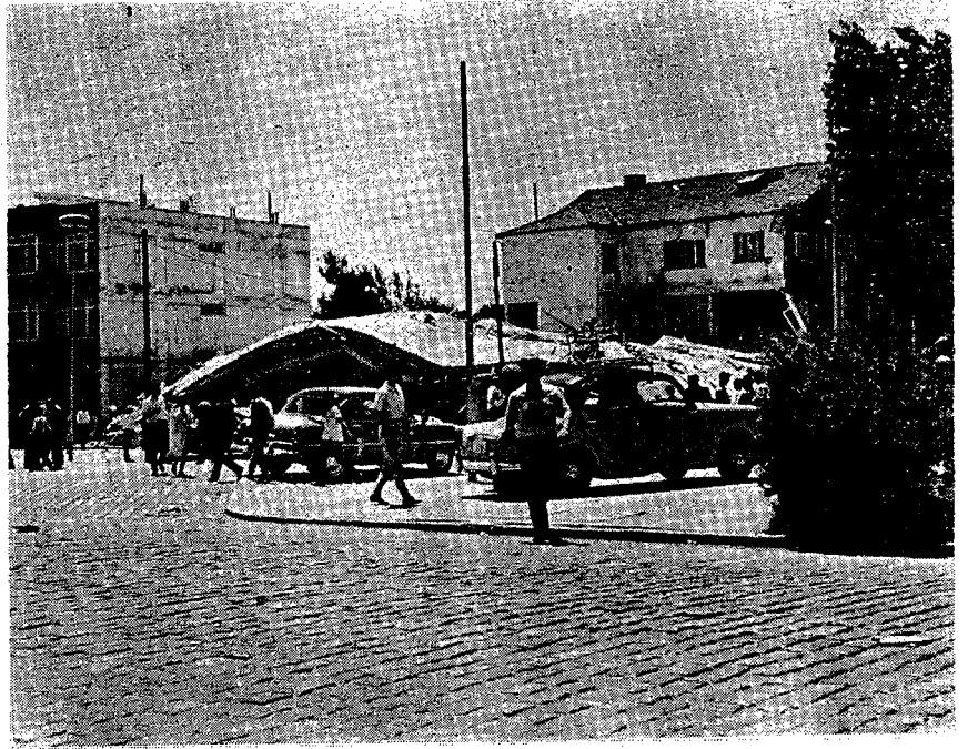
Ana cadde üzerinde henüz inşaatı ikmâl edilmeden zelzeleden yıkılan dört katlı bir betonarme karkıs bina. Harabenin iki yanında sağlam bir durumda görülen binalar ilgi çekicidir.
