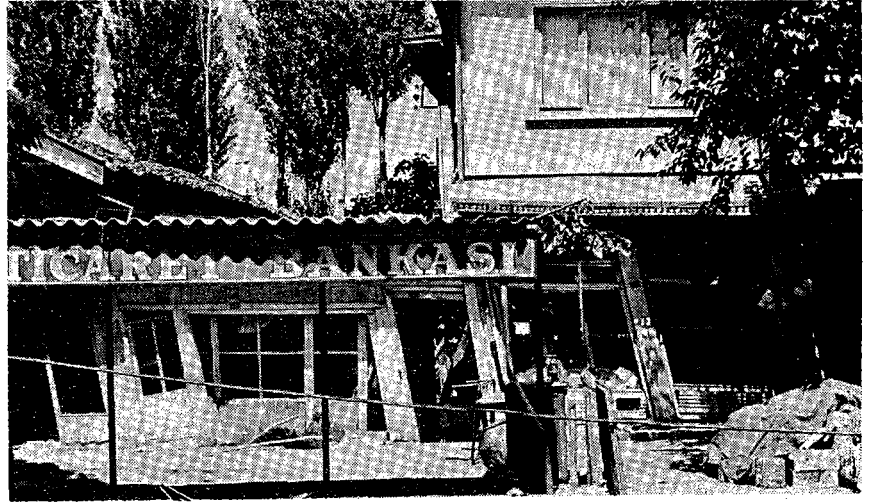
Yıkılan beş katlı apartmanların salınımları ile bir sıra komşu bina çökmüştür. Yu- karıdaki fotoğraf bu binalardan sonuncusu olup takriben bir metre genişlikteki bir aralık Ticaret Bankasından sonraki binalara hareketin intikalini önlemiş ve bu binalar gözle görülür derecede az hasar ile depremi atlattımlardır.
