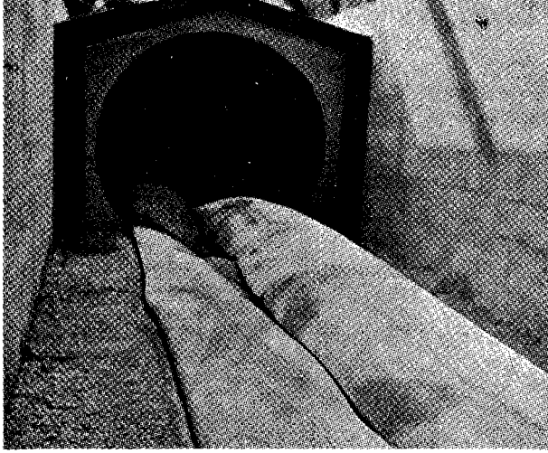
Resim : 9 — Pnömatik kauçuk kalıp devamında tekrar kullanılmak üzere kısa bir zaman sonra çekilir
