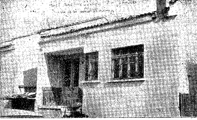
Afet yönetmeliğinde ön görülen köşe mesafesi bırakılmamış
