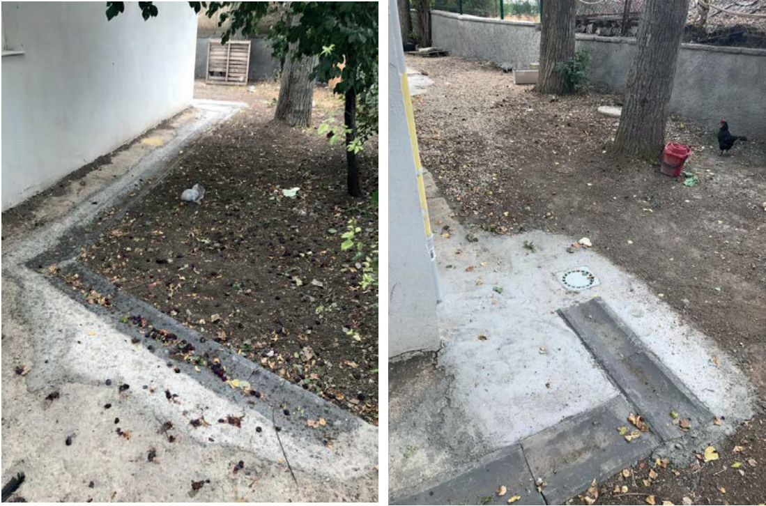
Şekil 3 Binaların çevresinde yapılan drenaj uygulamaları.
