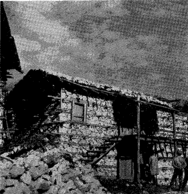
Manavgat - Sırtköy'de kuru duvarlı yapılar (Bu tarzın Akseki'de geniş bir yayılışı vardır.
