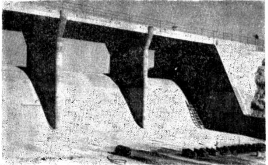
Çubuk II Barajı — Dolu Savak Sağ Sahilden Görünüş
