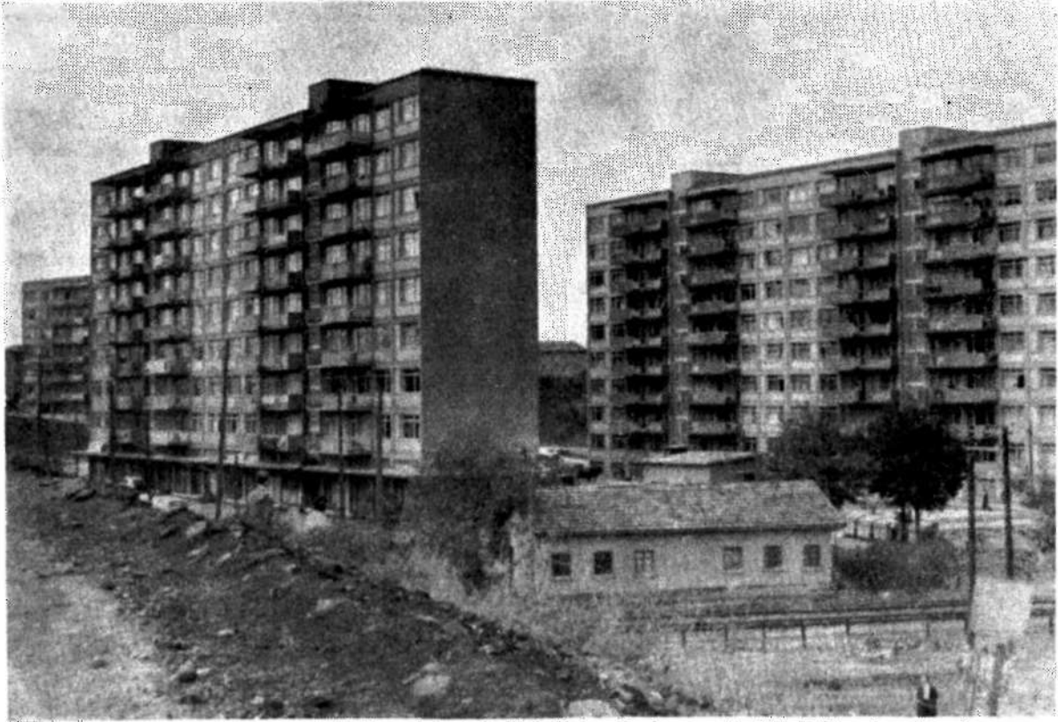
Ankara - Konya yolu üzerinde Eti Yapı Limited Şirketi tarafından yaptırılan Etiler Apartmanları. (Foto HERKÜL —
