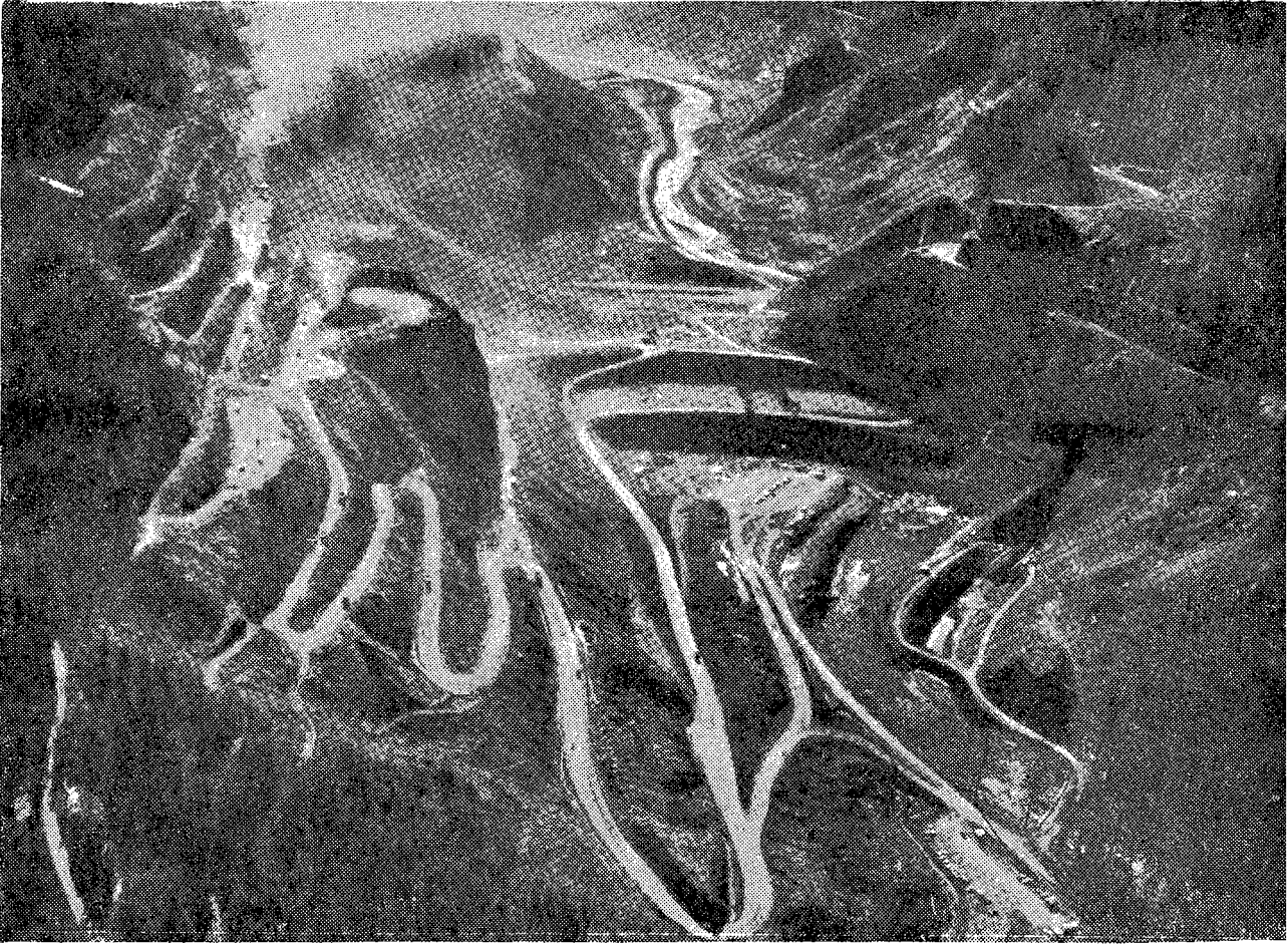
Birleşik Amerika'da «Cougar» Barajı Menbaya doğru bakış. Sol tarafta bazalt taşocağı. Serpantin yol gün 15,000 m 3 lük kaya nakil trafiğini kaldırmaktadır.
