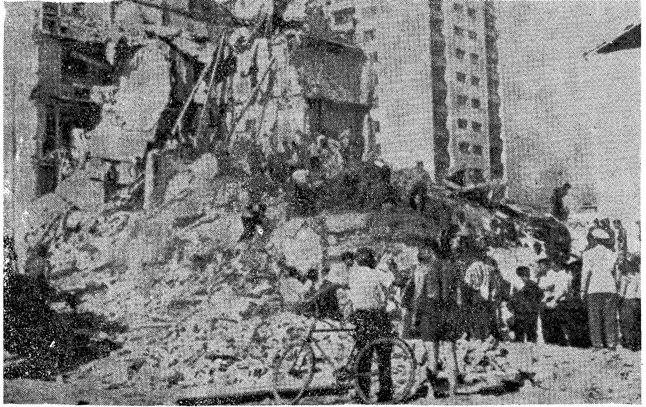
Yugoslavya'daki Zeldelede Yk Taşıyan Duvarlı Binalar Çkt... Çerçeve Sistemleri Dayandı. (Engineering News - Record. Ağustos 1963)
