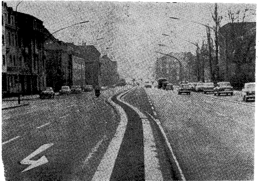
Şekil : 3 - «S» kurbu iki kavşak arasındaki uzunluk boyunca refüjde yapılmıştır. Bu suretle sola dönüş şeridi için azami uzunluk elde edilmiştir. (Essen'de Alfredstrasse)
