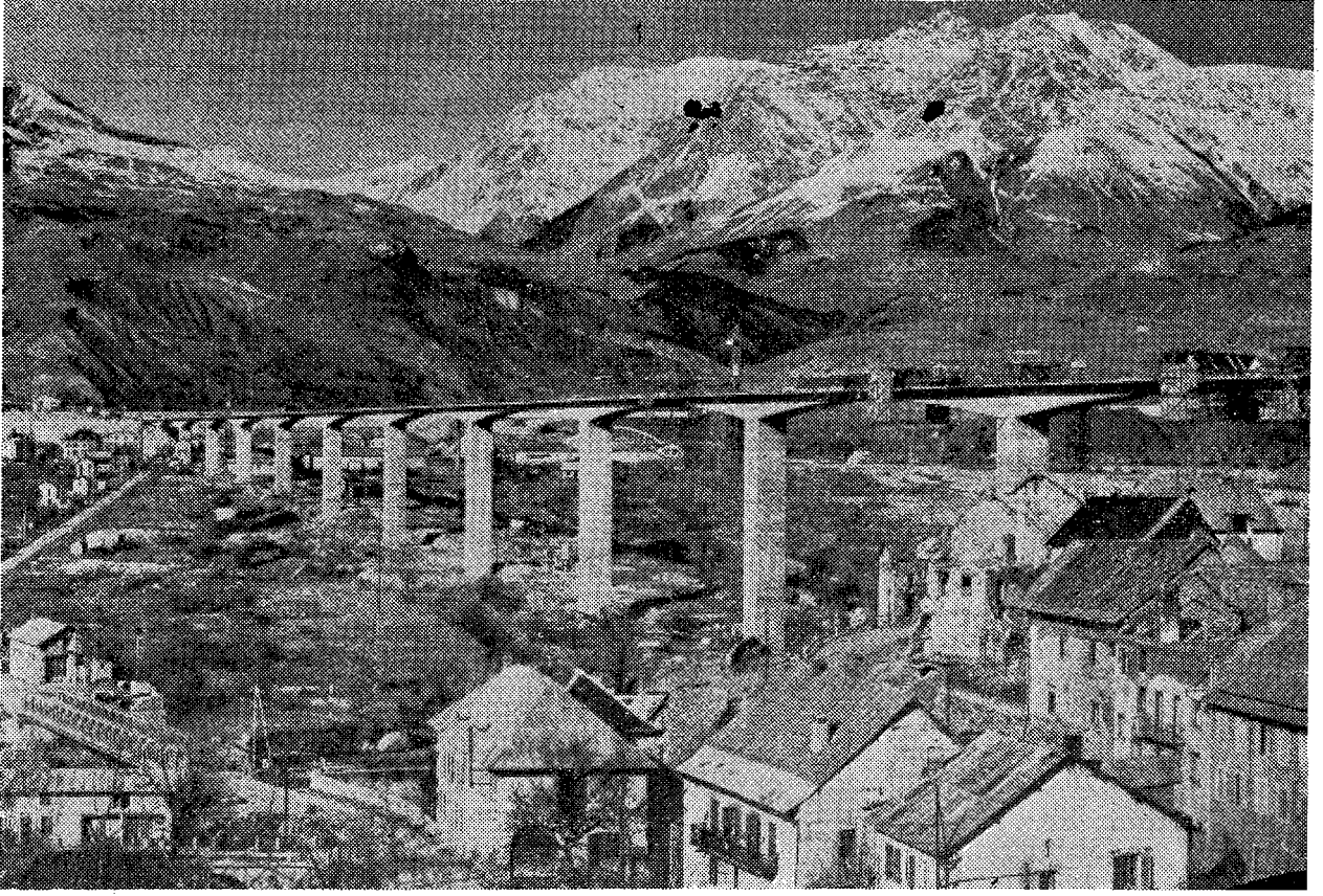
Fransa'da Durance nehri üzerinde Savines köprüsü ilkel gerilmeli beton olup belirli özelliği yüksek oluşudur. (World Construction Eylül - 1962)
