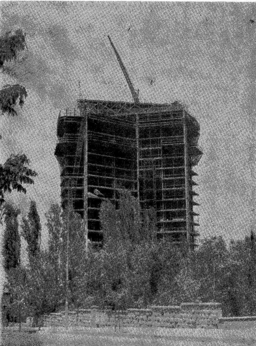
Güney cephesi genel görünüşü, 17 Nisan 1961 tarihinde durum
