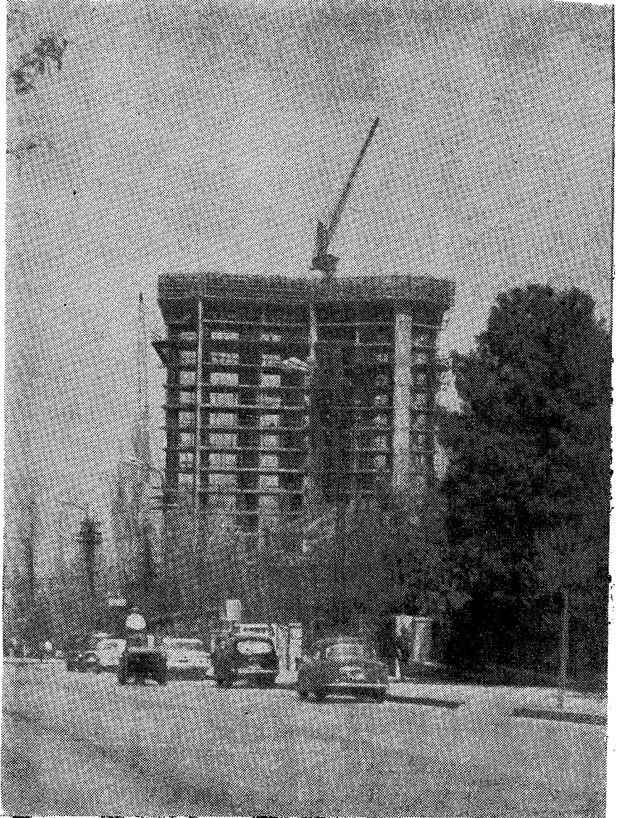
Atatürk Bulvarından Güney Cephesi Genel Görüşü
