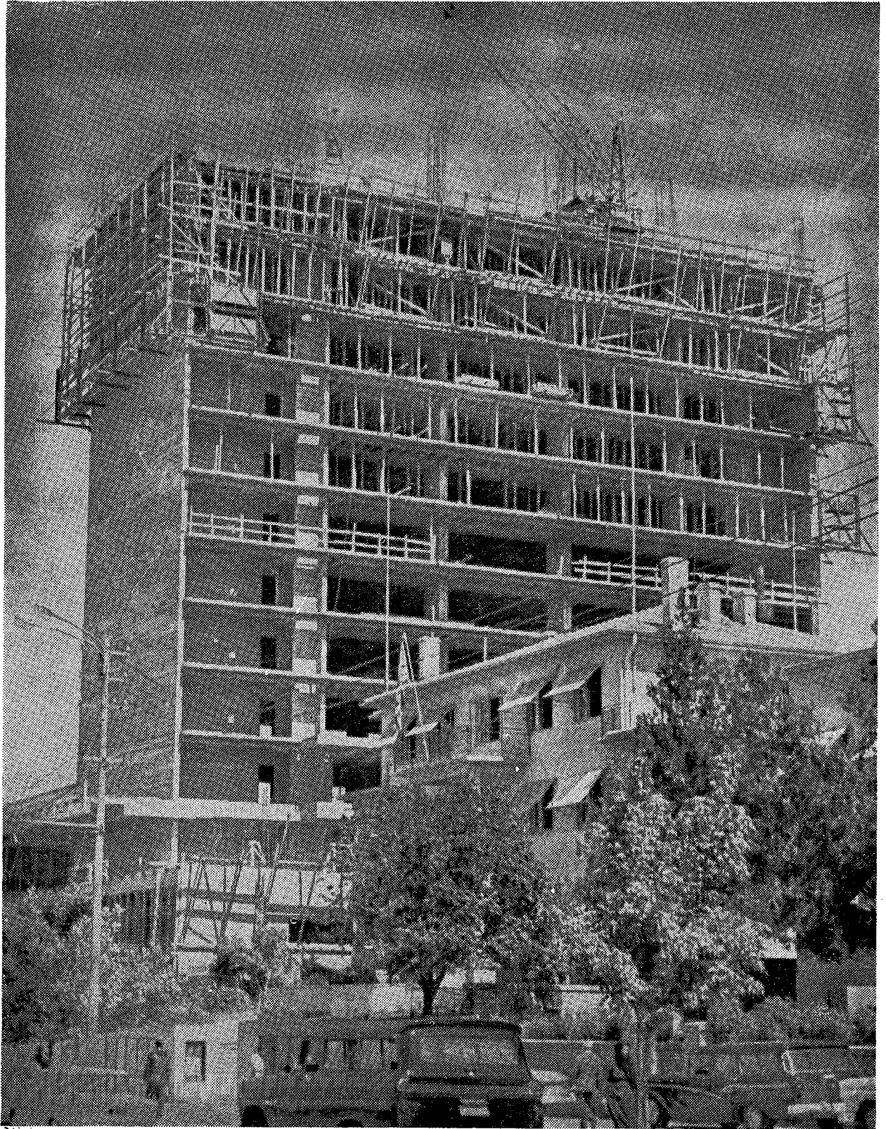
Ankara - Kızılay İşhanı inşaatı. 1 Ekim 1962 durumu.
