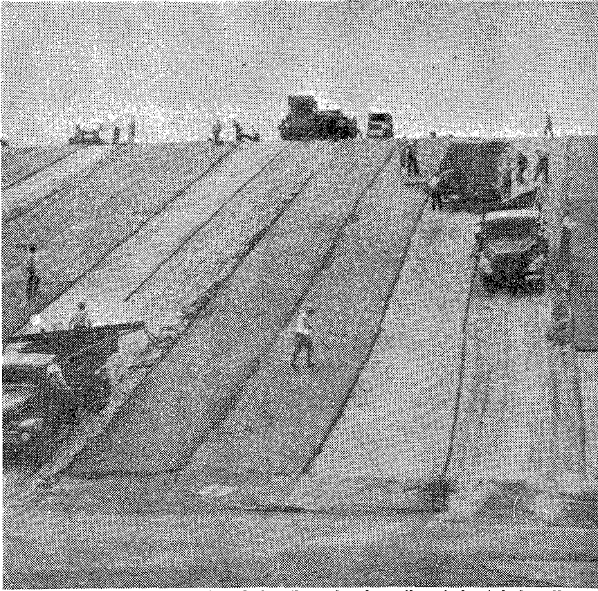
Asfalt karışımının alt tabaka (baz olarak serilmesi; bu tabaka elle tırmıklanmak suretiyle üniform kalınlık temin edilmiştir)
