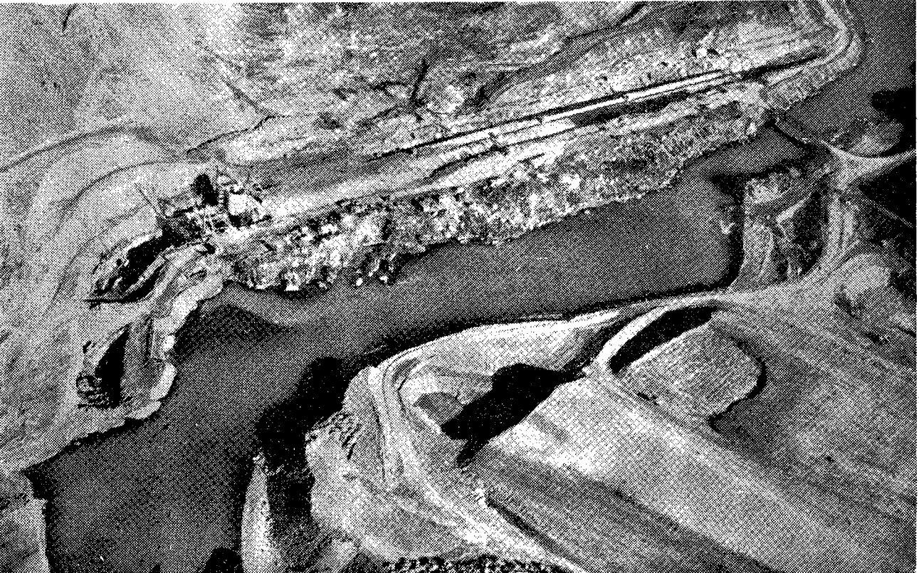
Derivasyondan evvel : Sağ sahilde beton menfez nehline paralel, ortada önde menba batardosunun ilk biter
