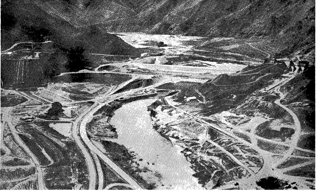
Benmore enerji projesi : Sağda üstte, beton su alma barajı ve dolu savak inşaatı görülmekte ve ortada toprak baraj şeklini almaktadır.
