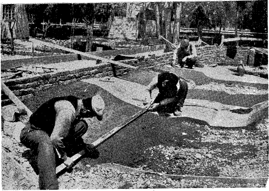
Foto 2 — En kesit aralarının betonlanması
