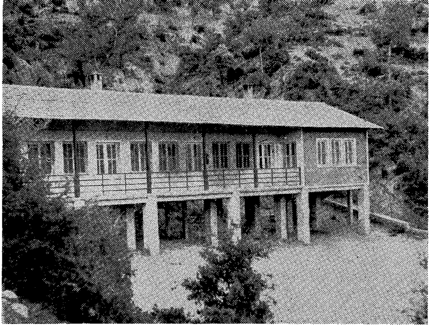
Resim : 4 — Kemer Barajı D.S.İ. Sitesi, ilkokul arka cephe
