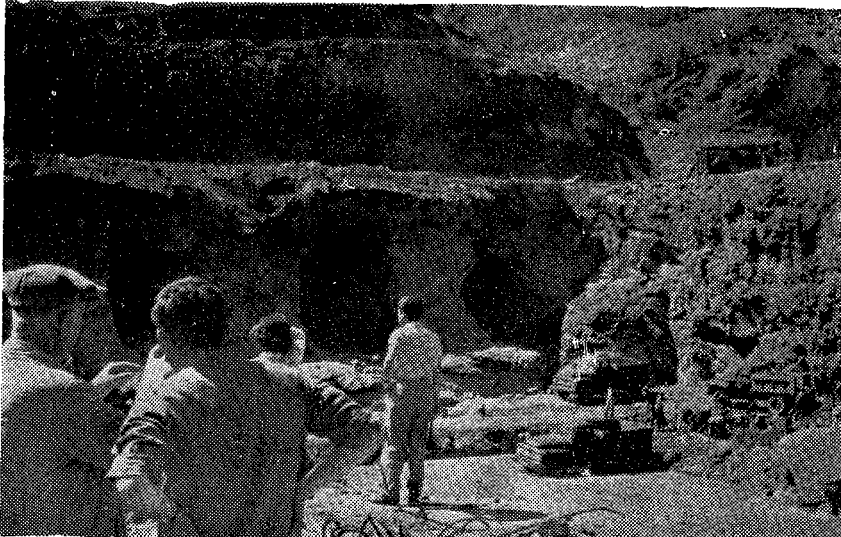
Almus Barajı kuvvet santrali kazısı ve türbinlere su veren tünellerin ağızları
