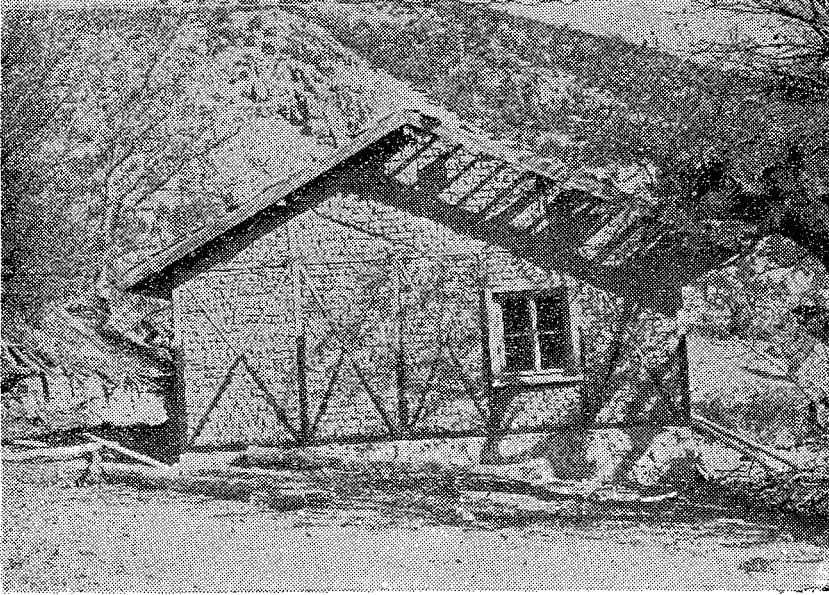
Şekil : 2 — Kendi evini yapana yardım usulü ile yapılmakta olan bir ev. Balıkesir - Kuşdere Köyü.
