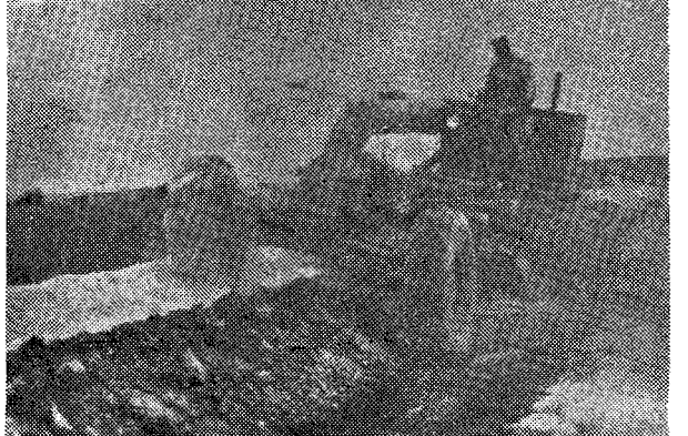
Foto No. 6 : Greyder ile kirecin karıştırılması
