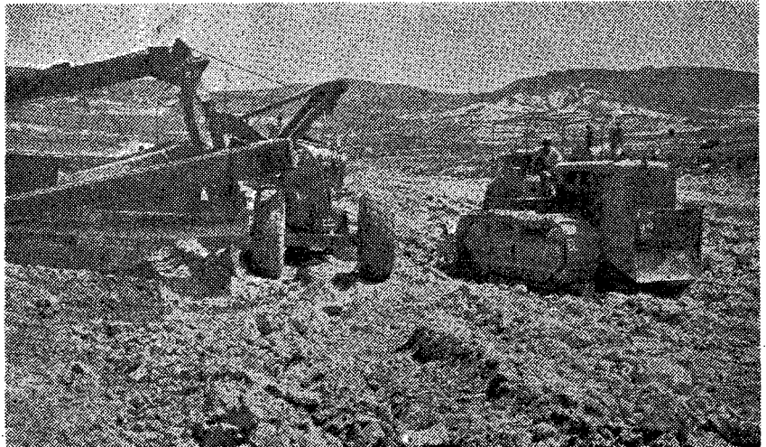
Afyon - Emirdağ yolunun 38. ve 40. Km. lerindeki yol çalışmalarından görünüş
