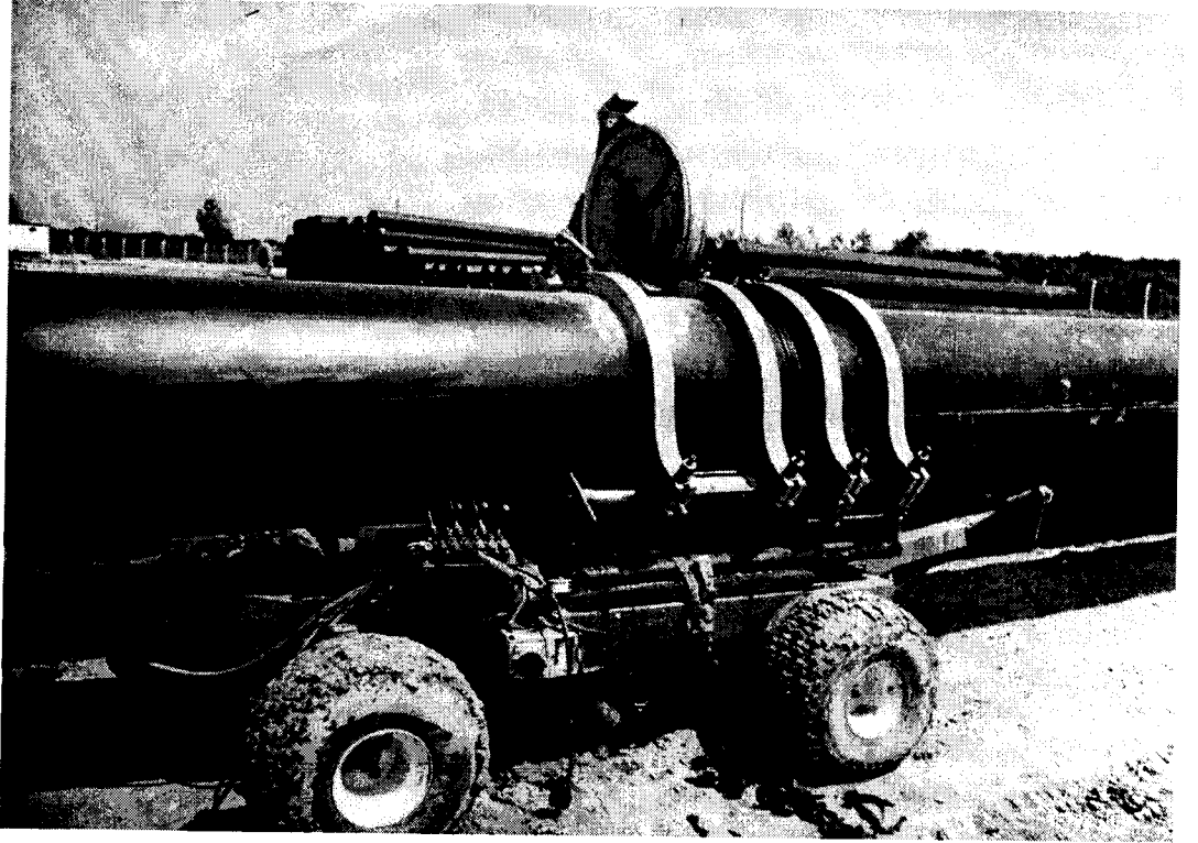
Resim 5.1 Denize indirilmeye hazır borular
