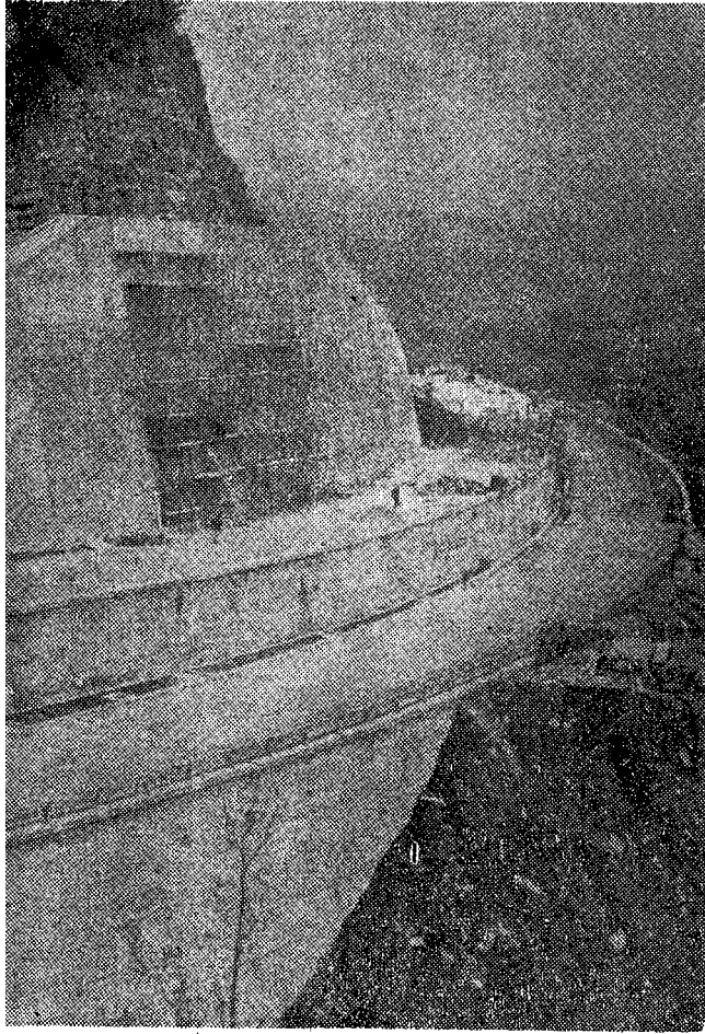
İtalya'da karayolu üzerinde bir istinat duvarı. Tabanda 6 m. genişlik yol seviyesinden itibaren 22.50 m. yükseklikte (ENR. 1 Haziran 1961)
