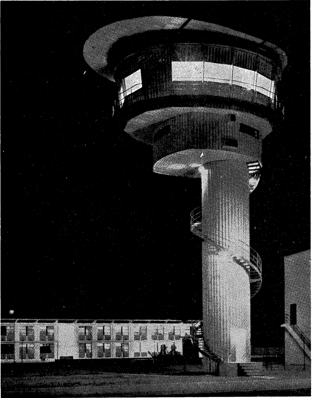
«Bougie» limanında, (Hassi-Messaoud.Méditerranée) payp-layn tesislerinde en modern usullere göre Fransız teknisyenleri tarafından inşa edilmiş olan kontrol kulesi. Kule platformu, hidrokarbon stokaj parkında kurulmuş bulunan 12 rezervuarın işleyişini temin eden manifoldun vanlarını idare eden güdümlü tesisleri ihtiva etmektedir. (Gece görünüşü)
