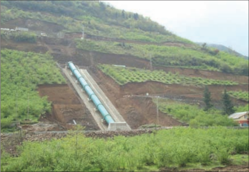
Şekil 9. Cebri boru montajının yapımı devam ediyor
