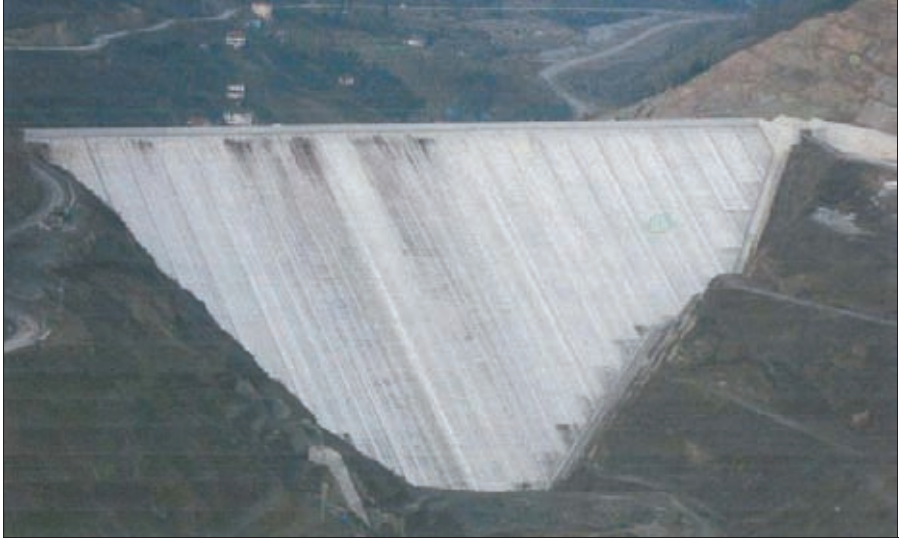
Şekil 3. Baraj gövdesi ön yüzeyi
