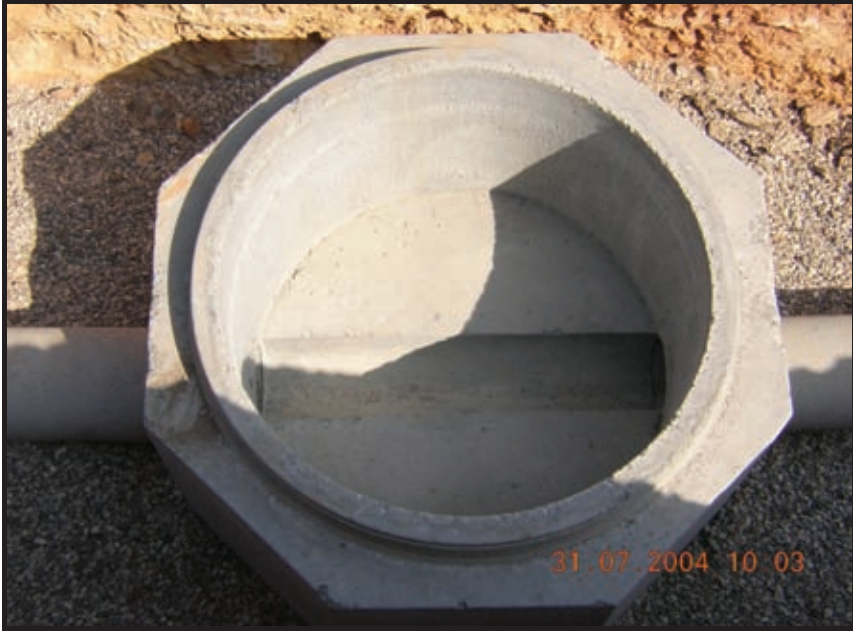
Fotoğraf 6. Kanalizasyon Baca İmalatı
