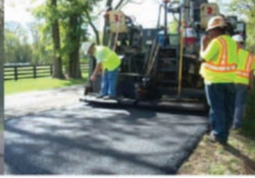
Şekil 8. Asfalt karışımlar yola serilirken görülüyor
