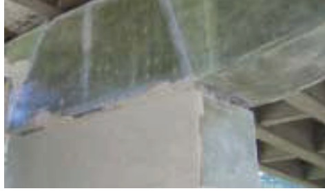
Şekil 5. Kolon kiriş birleşim bölgesinde CFRP uygulaması [9]
