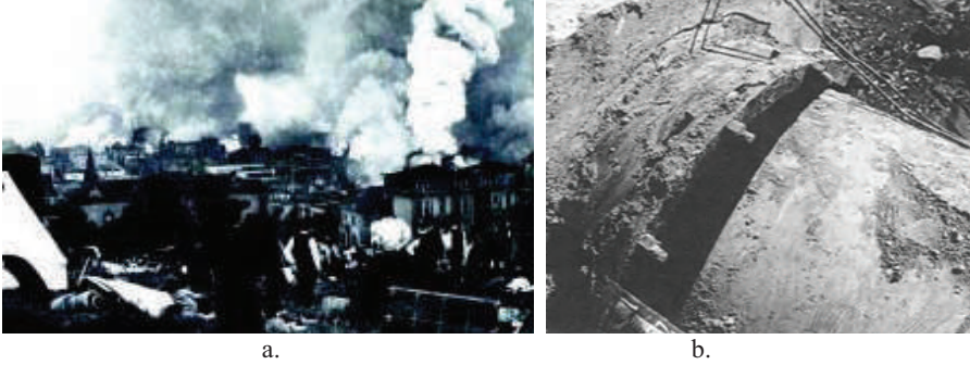
Şekil 1. (a).1906 San Francisco depremi sonrası yangın görüntüsü (b).1993 Hokkaido-Nansei-Oki depreminde boru hatlarındaki hasarlar
