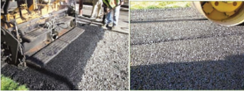
Şekil 4. Geçirimli asfalt serme-sıkıştırma işlemi
