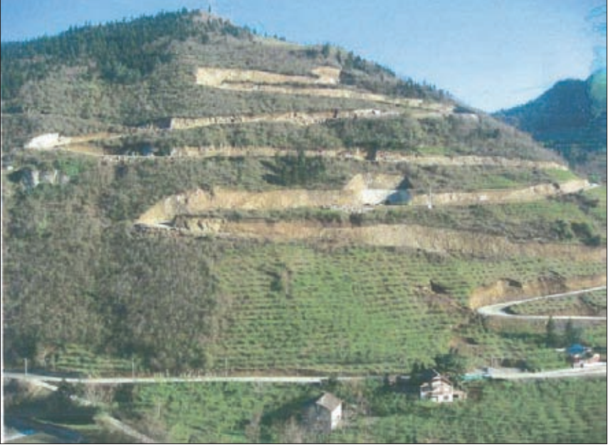
Şekil 8. Santral binası ve cebri borunun yapılacağı bölge
