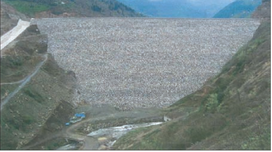
Şekil 6. Baraj kaya dolgu yüzeyi ve derivasyon tüneli çıkışı
