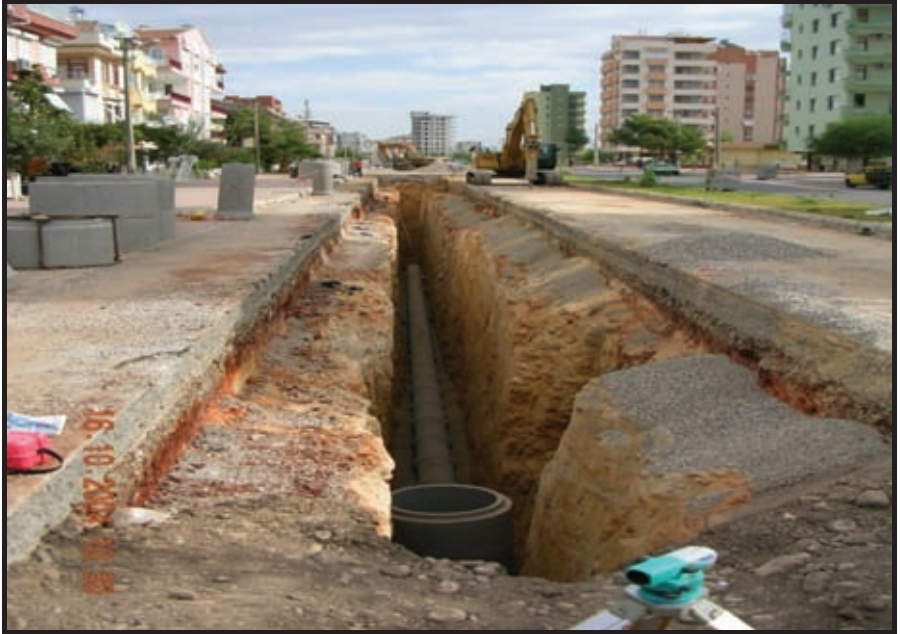
Fotoğraf 5. Kanalizasyon Hat İmalatı
