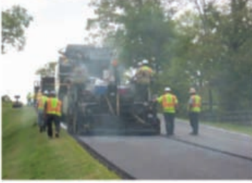
Şekil 8. Asfalt karışımlar yola serilirken görülüyor
