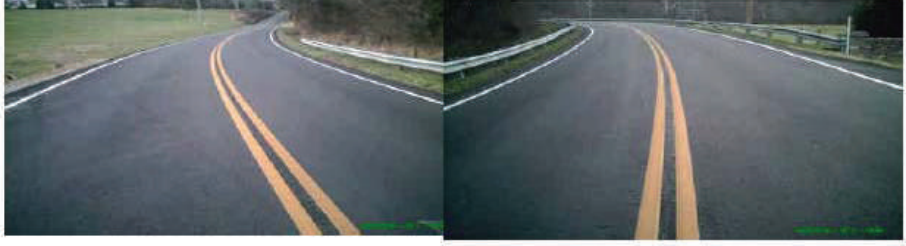
Şekil 10. Yolun yapımı bittikten sonra İKA ile BSK görünümü aynı
