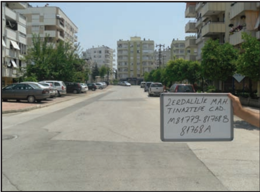
Fotoğraf 7. İş Bitim Sonrası Kanalizasyon Hattı
