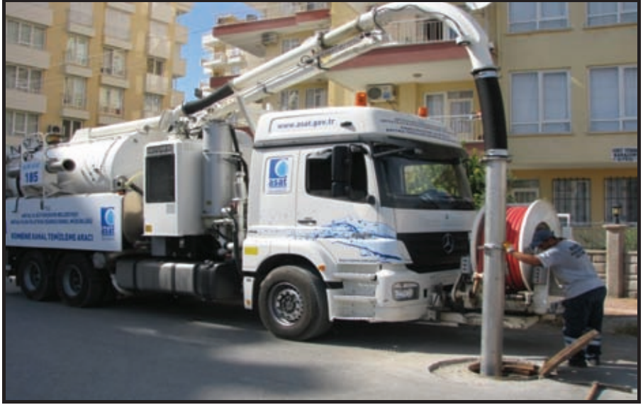
Fotoğraf 2. Kanal Temizleme Aracı
