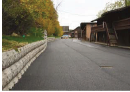
Şekil 5. Geçirimli asfalt uygulanmış bir yol kesimi
