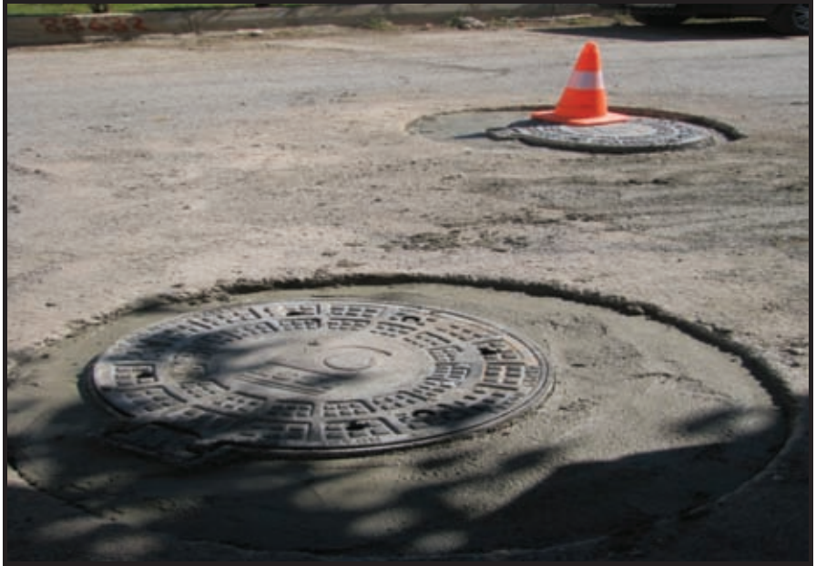
Fotoğraf 3. Kapak Yükseltme Çalışması
