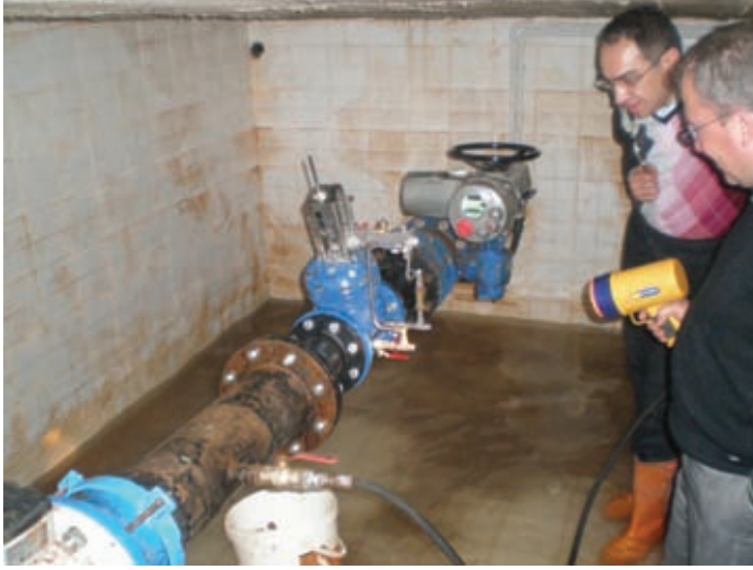
Şekil 6. Basınç kırıcı vana montajı
