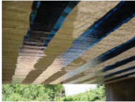
Şekil 6. Köprü Döşemesinde CFRP uygulaması[10]
