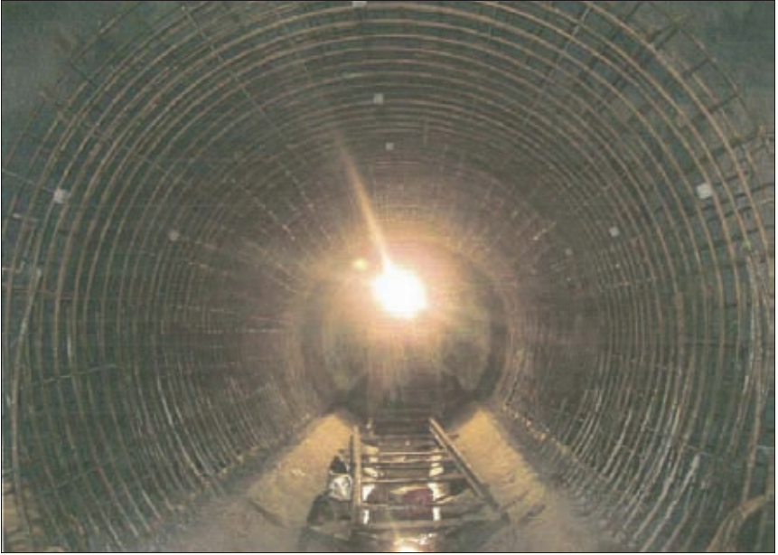
Şekil 7. Enerji tüneli inşaatından bir görüntü
