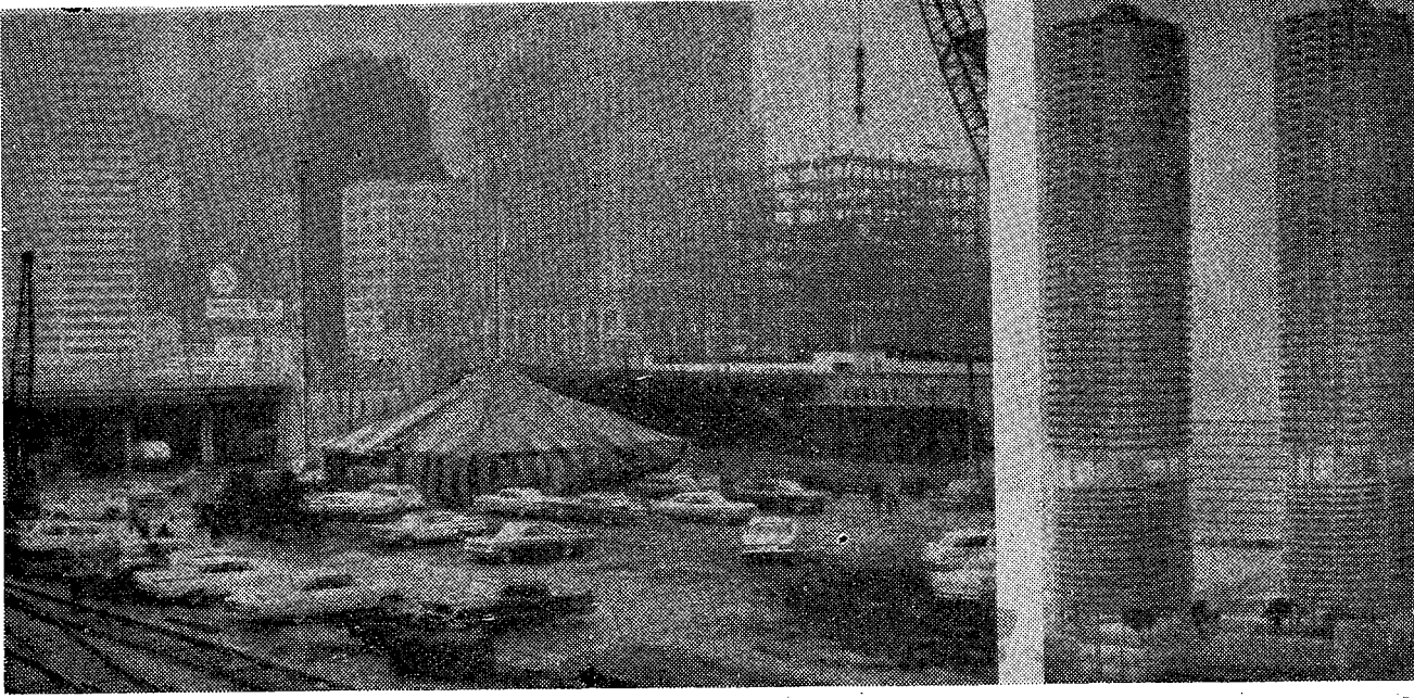
Marina City center'in iki binası dünyanın en yüksek binalarıdır. Chicago nehrinin kuzey kıyısındadır. Temel inşaatına başlanmıştır. (Solda). Sağ taraftaki makette ilk yirmi katı otopark olan ve üst kırk katında da 896 apartman dairesi bulunan binalar görülmektedir.
