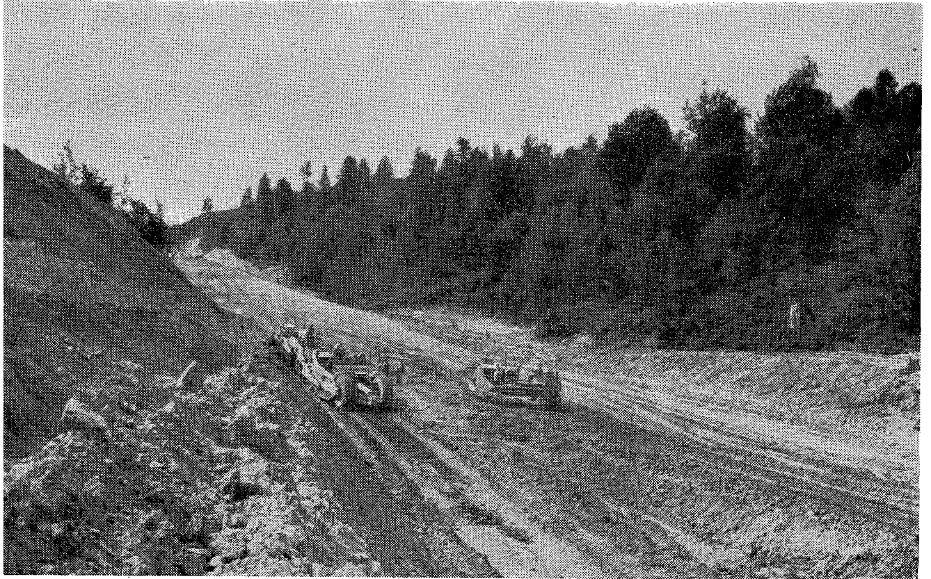
Bolu Dağı Yol çalışmaları Düzce-Yenıçağ
