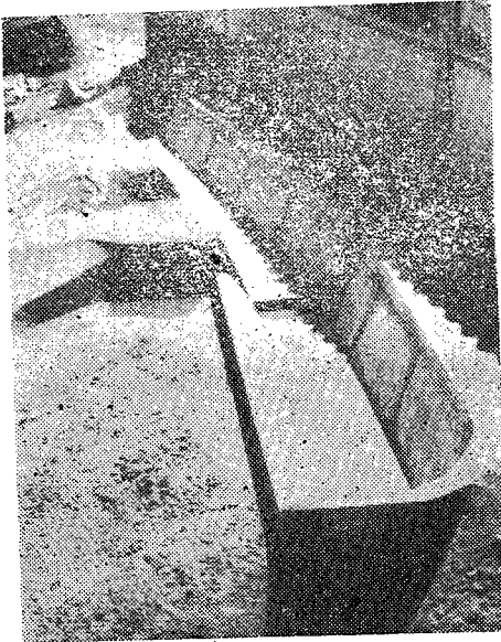
Şekil: 3 — Almus barajının dolu savak ve deşarj kanalının görünüşü (Menba tarafından).
