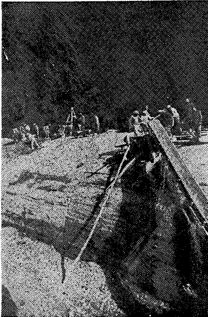
Şekil 3 — km 40 civarında Mestan II çığ tüneli (İnşaat safhası); beton 7.15 irtifaya elevatörle çıkarılıp, bu irtifada diğer anolara betonun el arabaları ile nakli ve bu elevatör yardımcı olarak beton dökümü yapılan anoya vinçle beton çıkarılması (şeytan arabaları ile) görülmüyor; 1959 iş mevsimi
