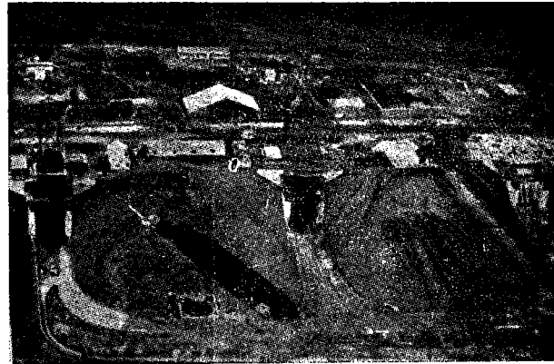
Şekil 6 — Roket motorlarının deneneceği sahada inşa edilmekte olan üç büyük stand. Önde deneme sırasında kullanılan soğutma suyunu sağdaki dinlendirme havuzuna sevkeden betonarme kaplamalı kanallar
