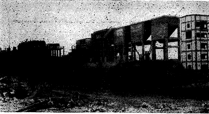
Kömür hazırlama binalarının bugünkü durumu (102 grubu)
