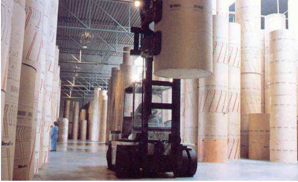
Şekil 1.1 Ağır yüklere maruz bir depo zemini
