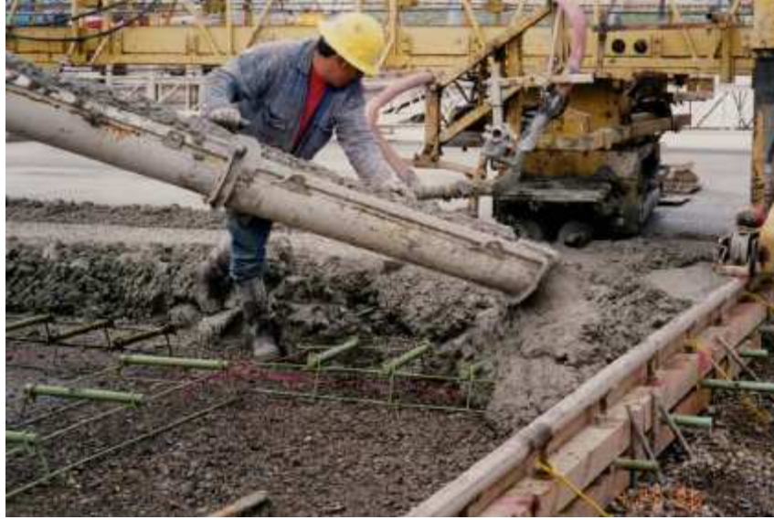
Şekil 3.75 Plakta derz kesimi yapılması planlanan bölgelerde beton dökümü öncesi hazırlanmış yük aktarma çubuklarının (dovillaların) yerleşimi
