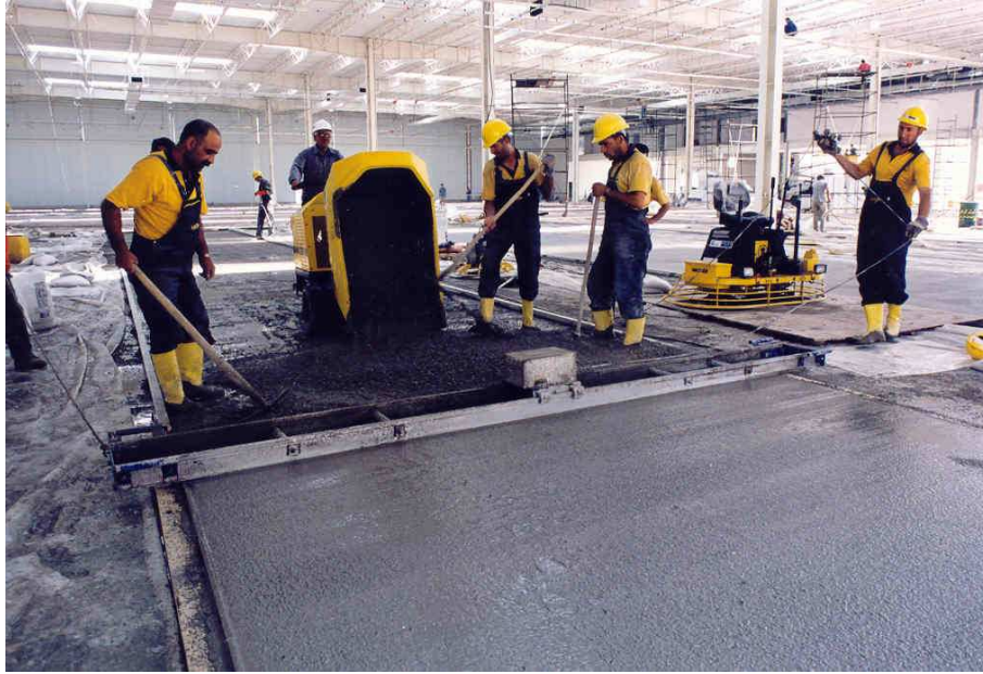
Şekil 4.7 Betonun motorlu el arabalarıyla taşınması
