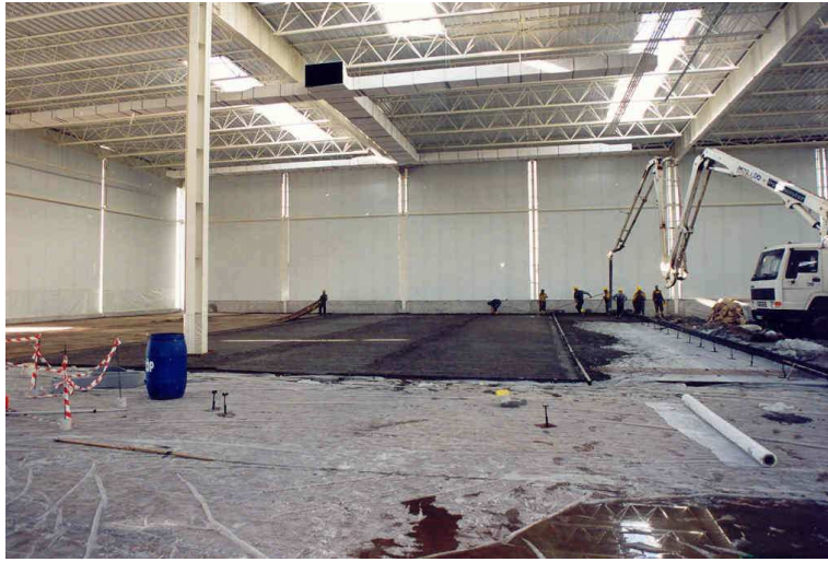
Şekil 4.17 Geniş alan dökümüne ait bir uygulama
