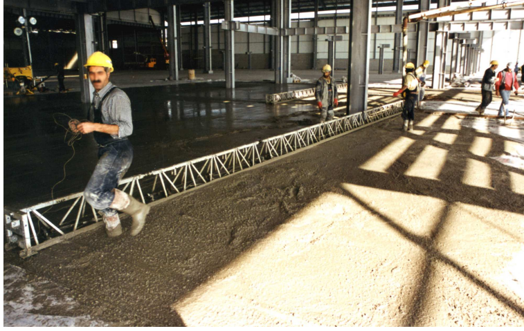
Şekil 4.16 Geniş şerit dökümü uygulaması
