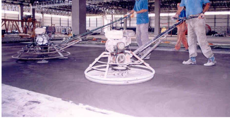
Şekil 5.5 Tekli helikopter (tepsi) ve bıçak ile beton yüzey tesviyesi
