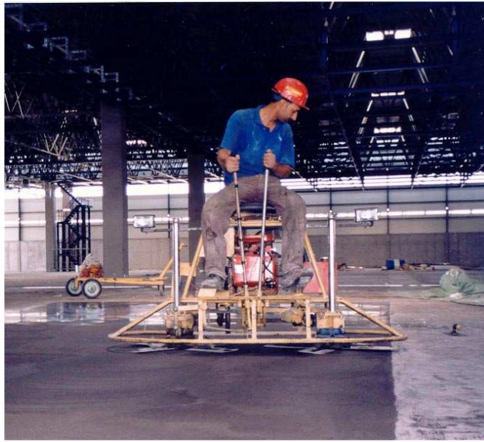
Şekil 5.6 Çift bıçakla yüzeyin düzeltilmesi
