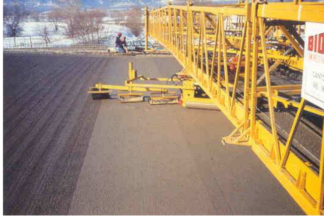
Şekil 5.7 Zemin beton yüzeyine süpürge çekilmesi
